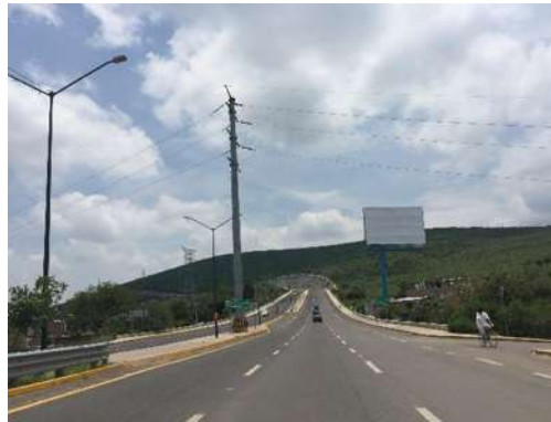
fotografía 54 inicio de cuarto cinturón sentido Av. Arandas a Héroe de Nacozari. PEGH jun/2020
