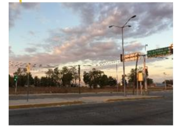
Fotografía SC6: cruce peatonal. PEGH ene/2020
