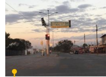
Fotografía SC3: señalización horizontal. PEGH feb/2020
