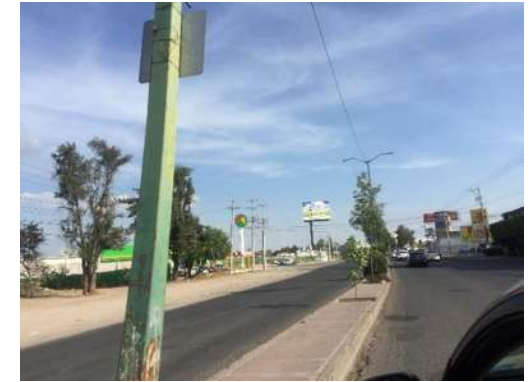
fotografía 69 Camellón existente Av. Paseo Solidaridad (tramo: Álvaro Obregón a Glorieta siglo XXI) PEGH
