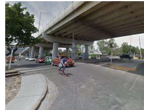
fotografía 62 Intersección de vía de tren av. Mariano J. García. PEGH. abril/2020
