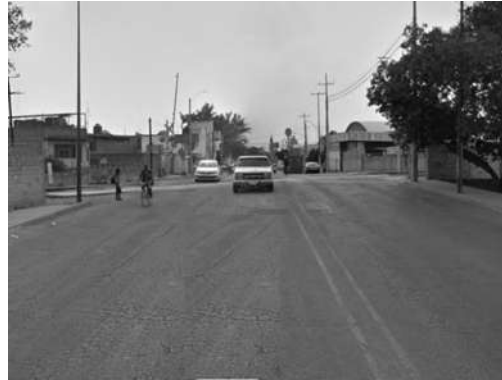
fotografía 68 Vía de tren calzada de Guadalupe. PEGH mayo/2020
