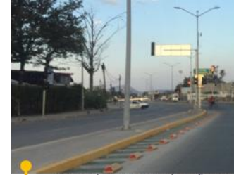
Fotografía SC2: ciclovia señalizada en arroyo. PEGH ene/2020
