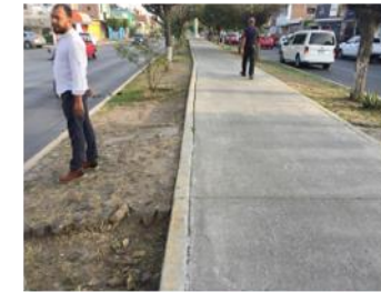
Fotografía MJ3: Pavimento en buenas condiciones. PEGH feb/2020
