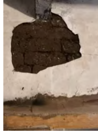
• Fig. 98 (Fotografía de sistema constructivo de muro preexistencias de vivienda.)
