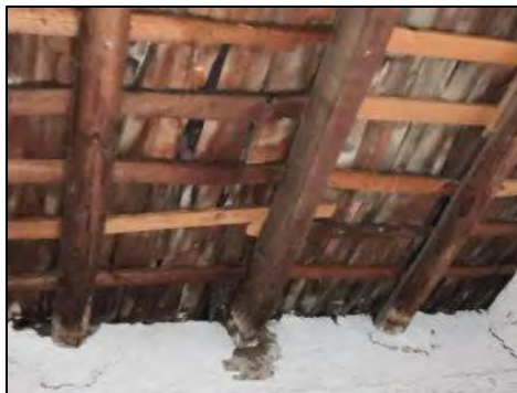
• Fig. 90 (Fotografía del estado actual de la vivienda haciendo notar la techumbre inclinada y sus materiales.)
