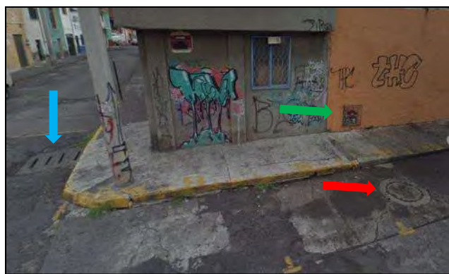
• Fig. 33 (Agua potable y alcantarillado en colonia Ventura Puente)
