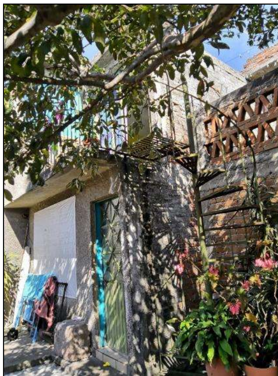
• Fig. 92 (Fotografía del estado actual de la vivienda hacia los cuartos posteriores)
