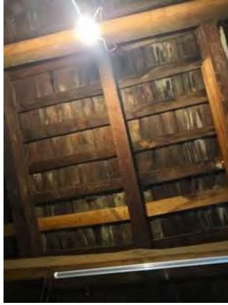
• Fig. 97 (Fotografía de sistema constructivo de techumbre preexistencias de vivienda.)
