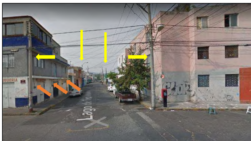
• Fig. 35 (Alumbrado eléctrico en colonia Ventura Puente)
