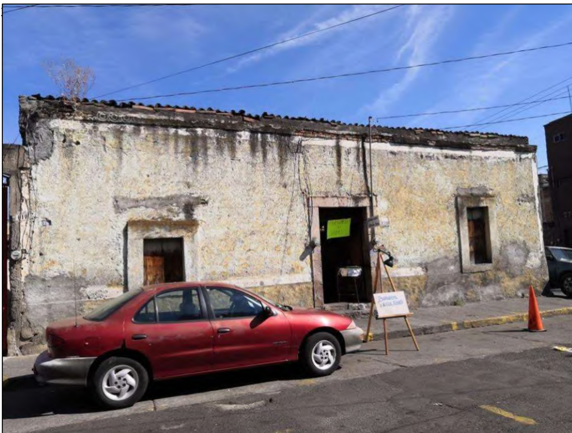
• Fig. 17 (Exterior de la vivienda sobre calle Abasolo)
