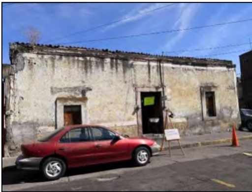
• Fig. 95 (Fachada principal desde calle Abasolo.)
