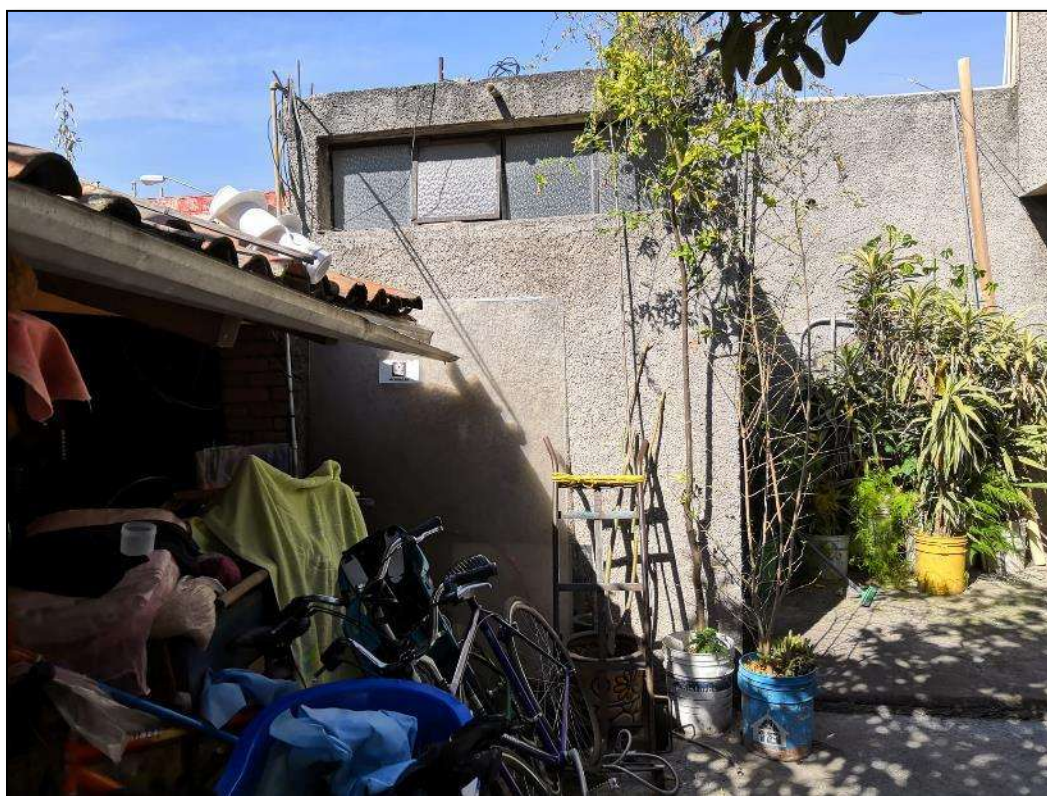
Fig. 79 (Fotografía del estado actual del patio en la vivienda con dirección al baño.)
