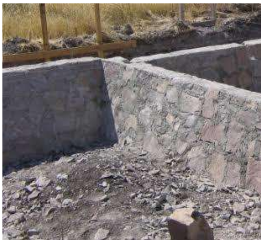
• Fig. 91 (Fotografía del supuesto cimiento ciclópeo que existe.)
