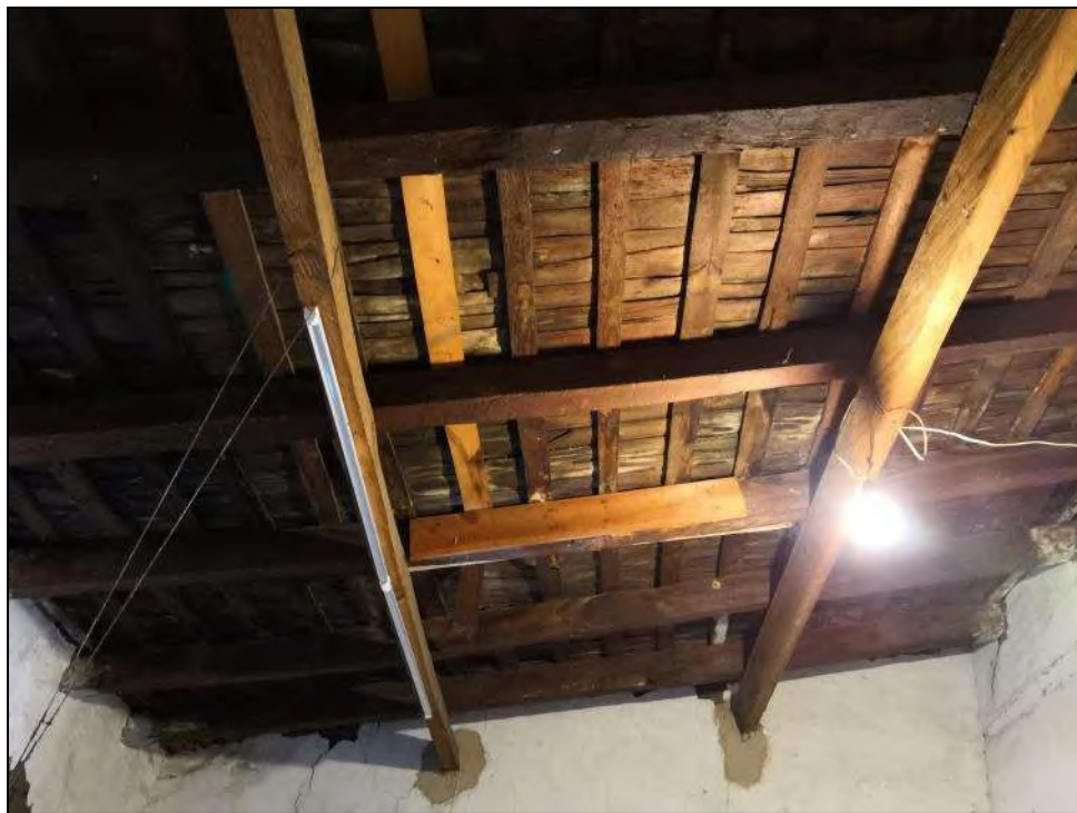
• Fig. 76 (Fotografía del estado actual de la vivienda haciendo notar la techumbre inclinada y sus materiales.)
