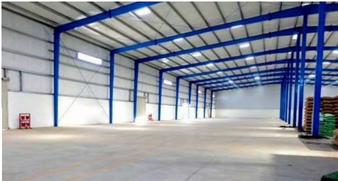
FIG. 5: Nave industrial. FUENTE: Rcccalles
