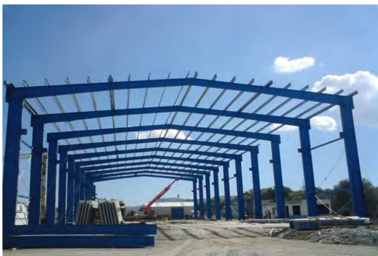
FIG. 81: estructura metálica en naves industriales
