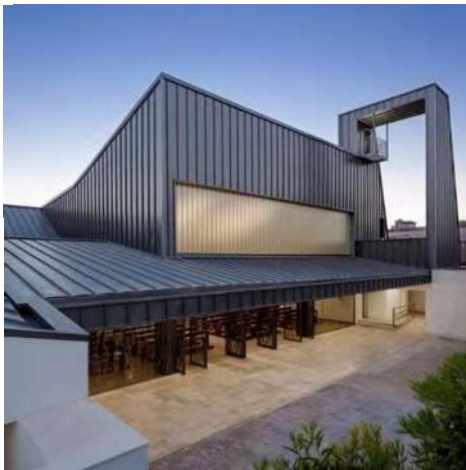
FIG. 6: Nave industrial. FUENTE: Rcccalles
