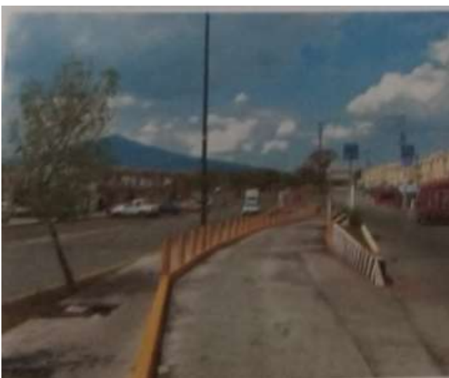
Fig. 28 pavimentos en villas del pedregal
