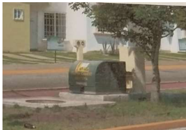
Fig. 25 luminarias en villas del pedregal
