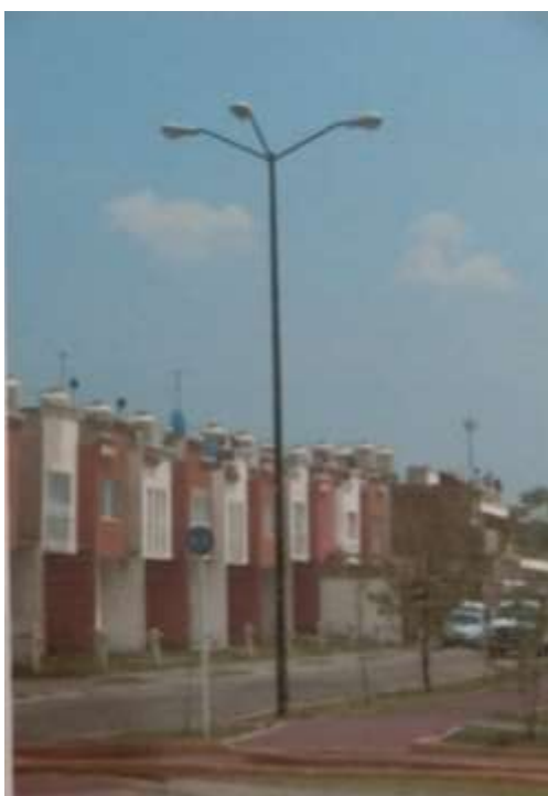
Fig. 26 Iluminarias en villas del pedregal
