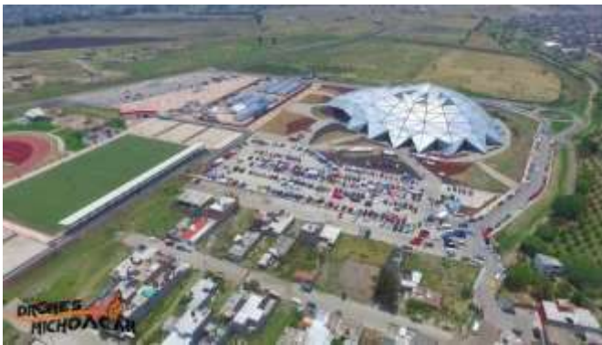
Fig.35 Vista aérea del complejo deportivo bicentenario
