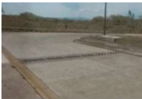
Fig.24 agua potable y alcantarillado en villas del pedregal.
