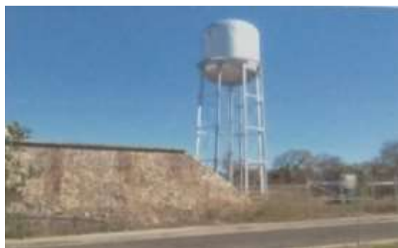
Fig.22 agua potable y alcantarillado en villas del pedregal.
