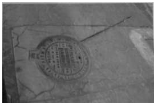
Fig.23 agua potable y alcantarillado en villas del pedregal.
