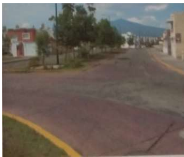
Fig. 29 pavimentos en villas del pedregal
