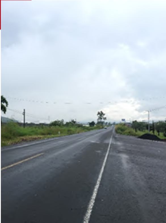
Ilustración 10: Carretera Los Reyes-Uruapan. Fuente: Autoría propia.
