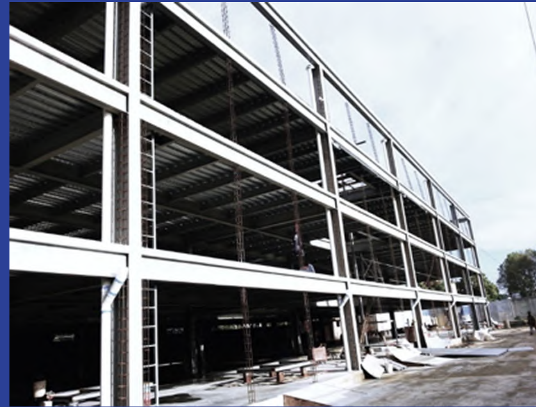
Ilustración 37: Sistema losacero.
