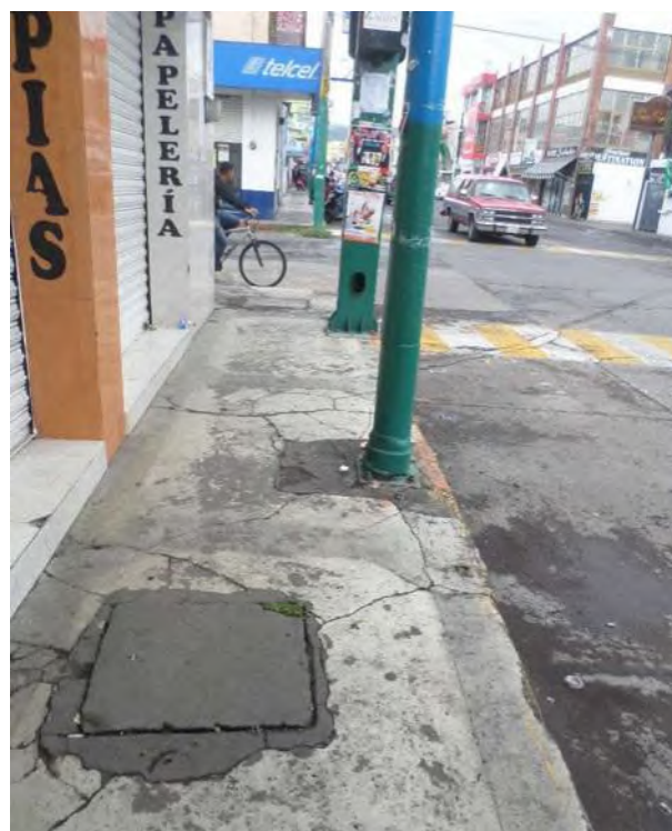
Ilustración 3. " investigación de campo zacapu" Las banquetas se encuentran en malas condiciones, las grietas crean desniveles, dificultando la circulación en ella. Foto tomada por Eduardo Alfaro Butanda
