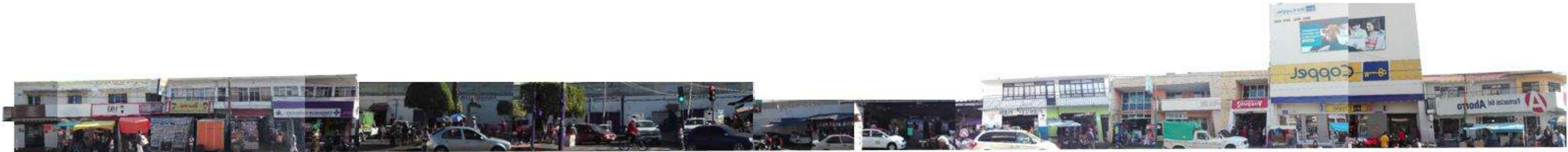
Larguillo fotográfico de fachadas que ven al Suroeste, correspondiente entre las calles 5 de Mayo y General Pueblita
