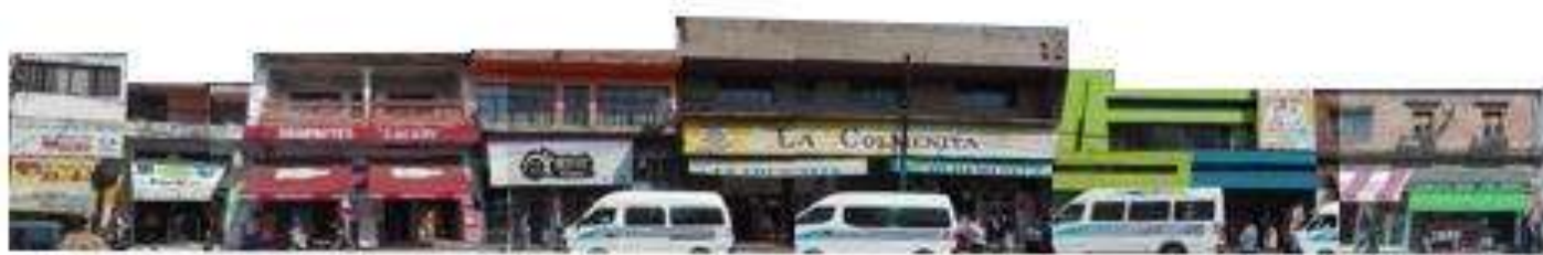
Larguillo fotográfico de fachadas que ven al Noreste, correspondiente entre las calles 5 de Mayo y Avenida Justo Mendoza
