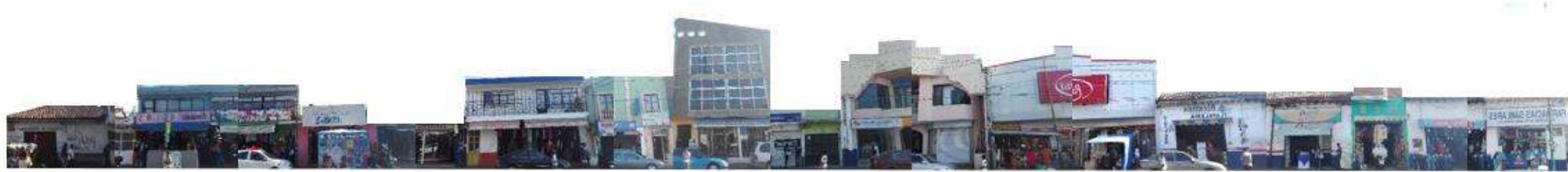
Larguillo fotográfico de fachadas que ven al Suroeste, correspondiente entre las calles Melchor Ocampo y 5 de Mayo
