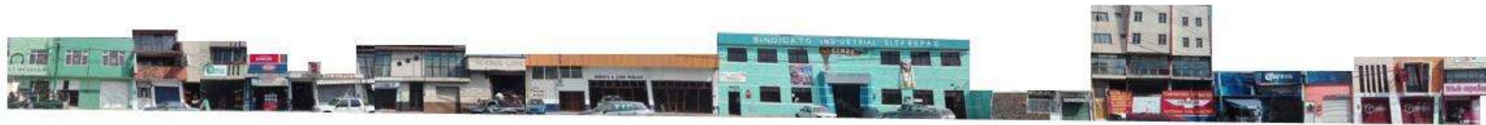
Larguillo fotográfico de fachadas que ven al Noreste, correspondiente entre las calles Ignacio Altamirano y 5 de Febrero
