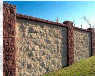
IMAGEN 33 Fotografía donde se aprecia el muro de block con acabado aparente. Fuente: IAC, 2020, Paracho.
