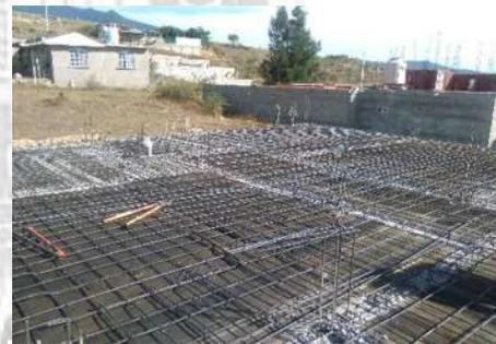
IMAGEN 34 Fotografía donde se aprecia la losa maciza Fuente: IAC, 2020, Paracho.
