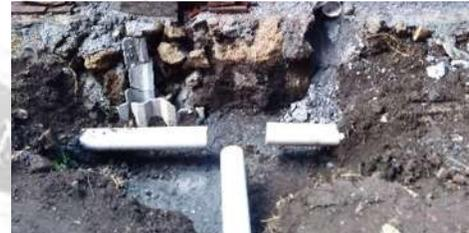
IMAGEN 36 Fotografía donde se aprecia la instalación tuberías de 4pg de aguas negras. Fuente: IAC, 2020, Paracho.
