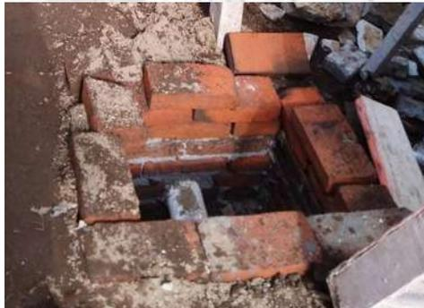
IMAGEN 37 Fotografía donde se aprecia la instalación tuberías en registro de tabique de barro rojo recosido. Fuente: IAC, 2020, Paracho.
