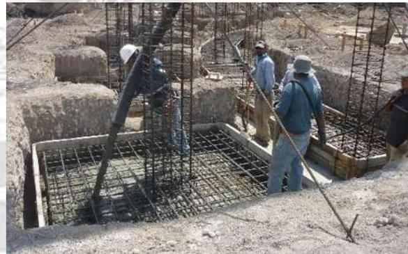
IMAGEN 31 Fotografía donde se aprecia el personal de trabajo anclando una columna hacia la parrilla armada. Fuente: IAC, 2020, Paracho.
