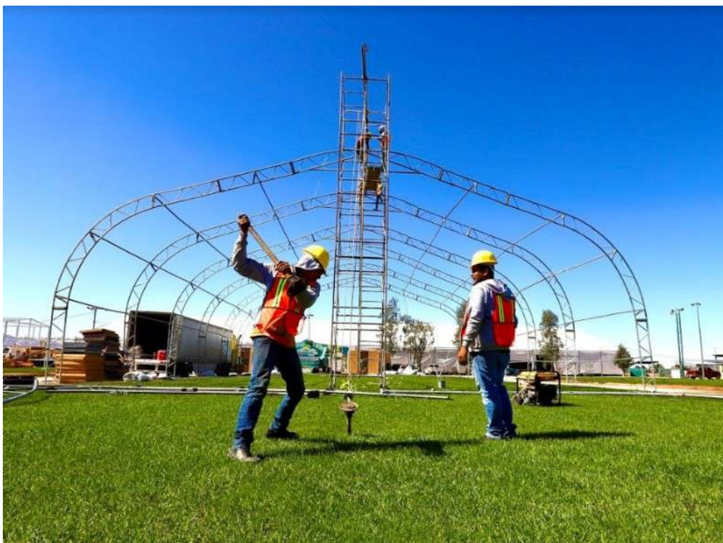
Imagen 63. Habilitado de estructura para las naves efímeras que alojarán la Expo Agrobaja. Imagen: elimparcial.com
