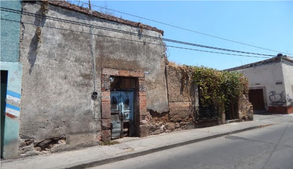
ilustración 31.-Inmueble ubicado en calle Guerrero #632 (Fotografía). Tomada por autor.
