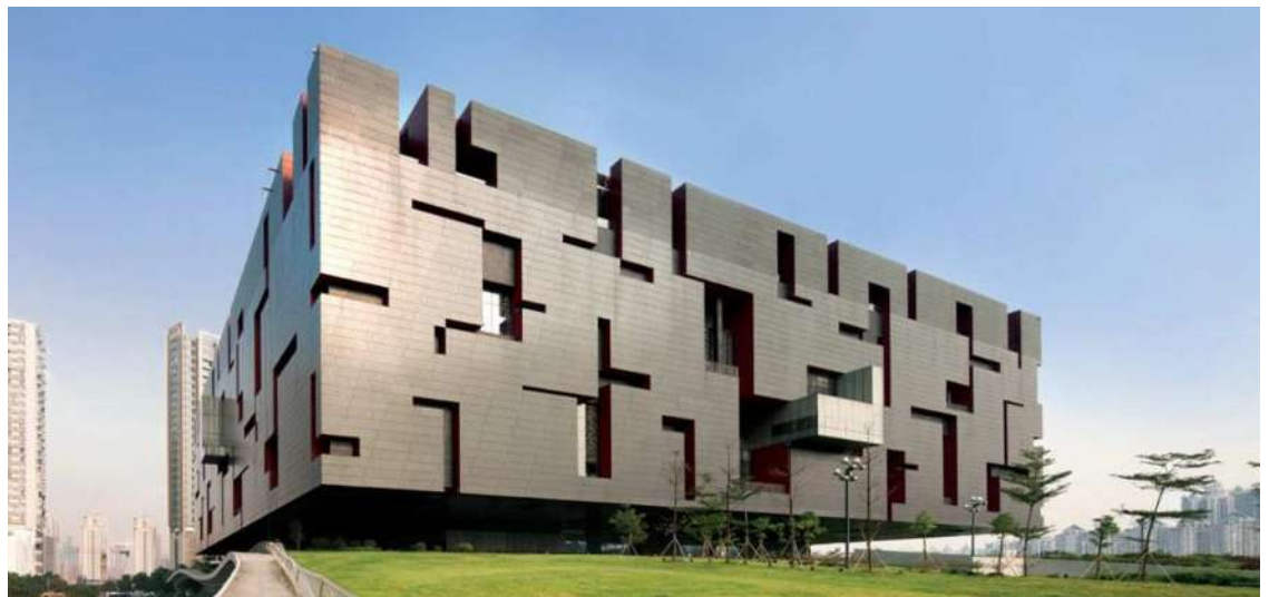
Imagen 7. Fachada del museo Guangdong. Autor: Marcel Lam. Año: 2015. Fuente: http://www.arch2o.com/guangdong-museum-rocco-design-architects/ . Fecha de consulta: 02/07/2017.
