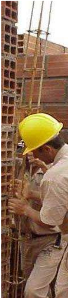
Imagen 28. Proceso de construcción.
