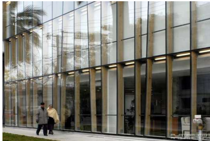
Imagen 32. Caja de Compensación La Araucana, Talca – Chile. Autor: José Tomas Franco. Año: 2011. Fuente: http://www.archdaily.mx/mx/02-77161/en-detalle-muro-cortina/03-muro-cortina .
