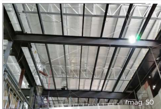
Imag. 48-51. Desmontaje de Cubierta Anterior en Ampliación
