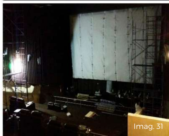
Imag. 26-31. Remodelación de Salas 4, 7 y 8
