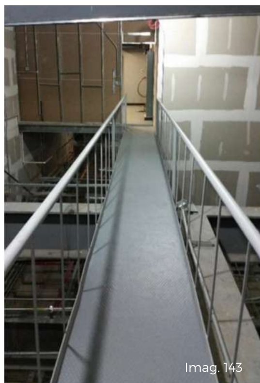
Imag. 143-144. Construcción de Paso de Gato
