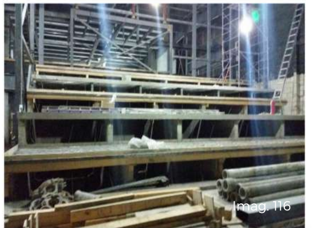
Imag. 111-116. Construcción de Raisers Sala 4
