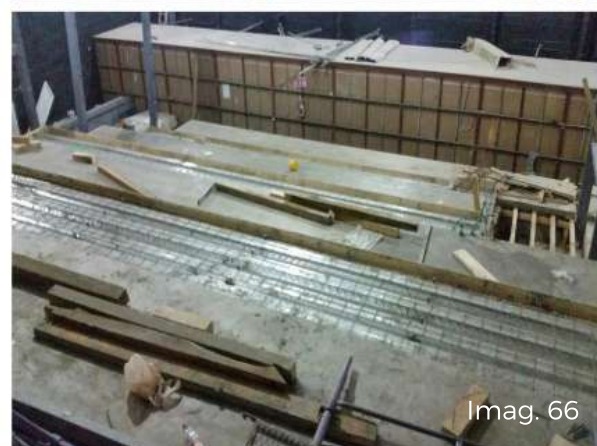
Imag. 64-66. Construcción de Raisers de Gradas.
