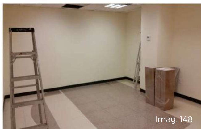
Imag. 145-148. Construcción Cuarto de Empleados
