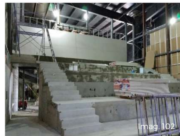
Imag. 97-102. Construcción de Raisers Sala 3
