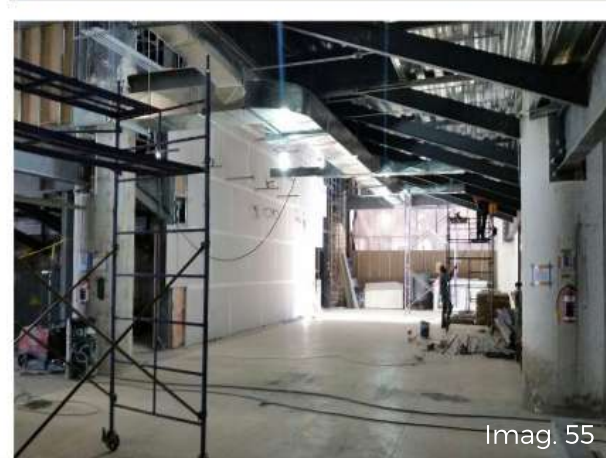
Imag. 52-55 Estructura en el área de Lobby
