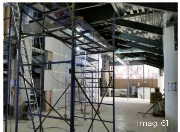
Imag. 56-61. Estructura en Ampliación.
