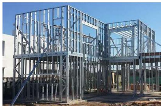
Figura N° 5.2 “Estructura de acero con PTE y perfil tipo IR”
