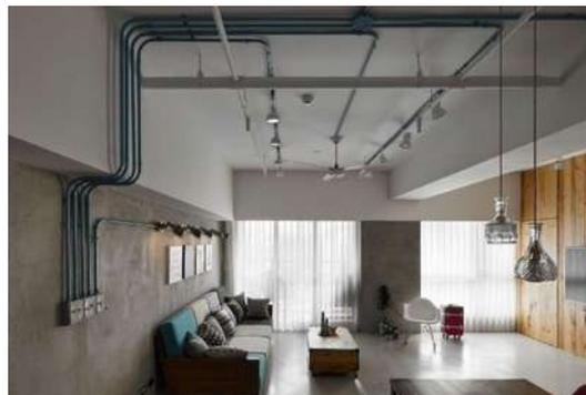
Figura N° 5.11 "Instalación eléctrica aparente"
