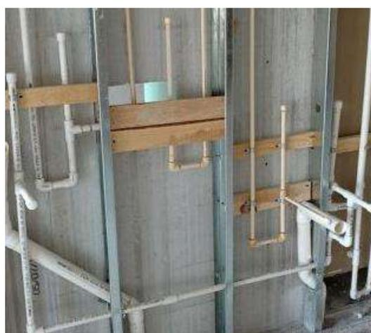
**Figura N° 5.7** "Instalación hidráulica con tubo CPVC"
