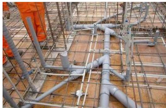
**Figura N° 5.8** "Instalación sanitaria PVC"
