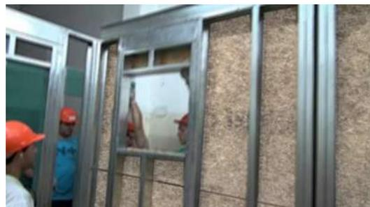
Figura N° 5.3 “Muro de panel plástico”
