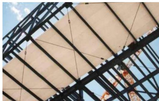
Figura N° 5.4 “Losa estructural con panel plástico reciclable”
