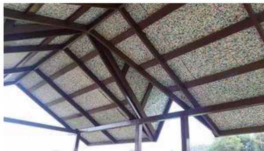
**Figura N° 5.5** "Losa estructural con panel plástico reciclable"
