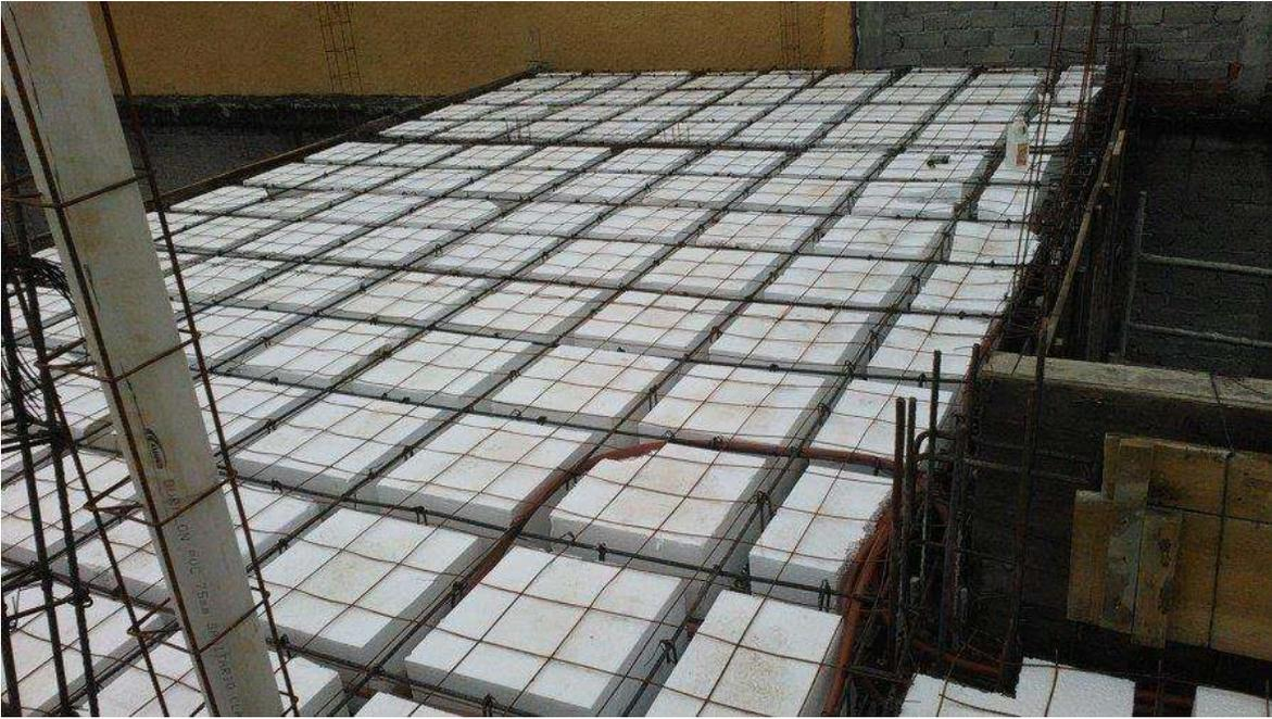
*Imagen 124.- Armado de losa reticular*
