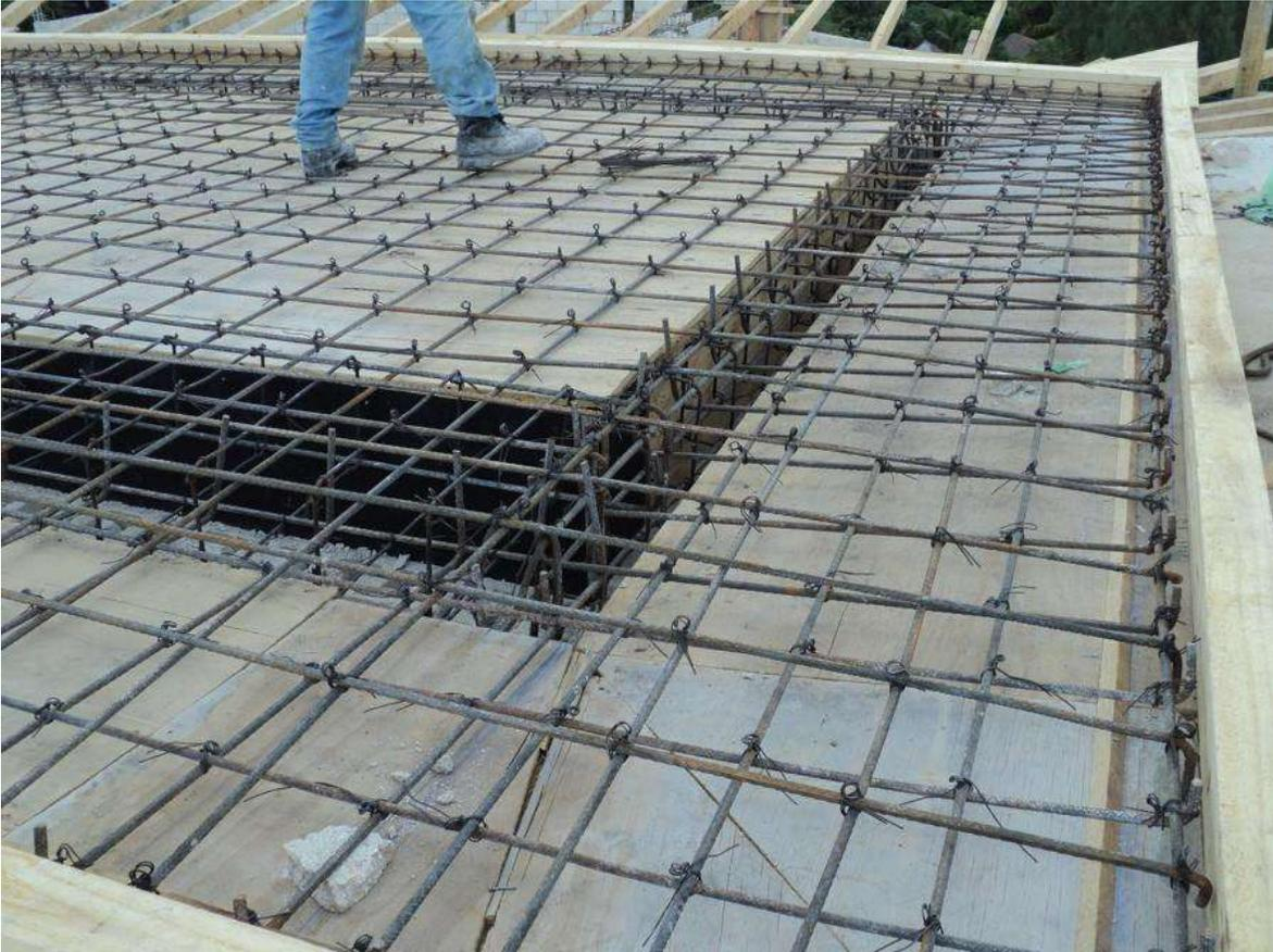
*Imagen 123.- Armado de losa maciza*
