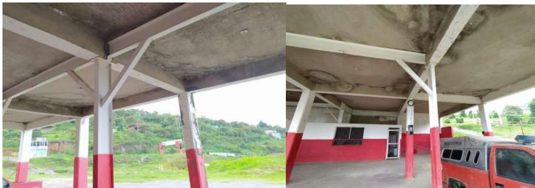
imagen 10.2 Estacionamiento de patrullas y motobombas. Fotos tomadas por el autor (octubre 2019)
