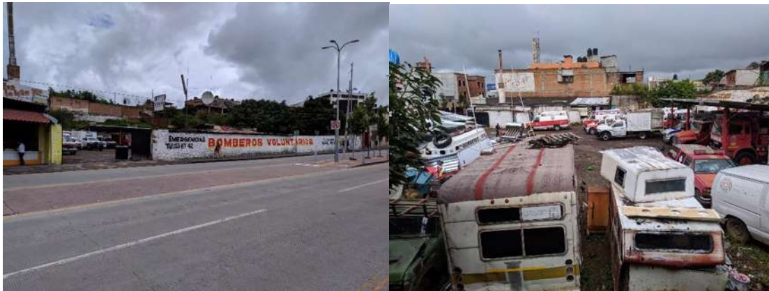
Imagen 6 Fachada principal y del patio de maniobras. Foto tomada por el autor (octubre 2019)
