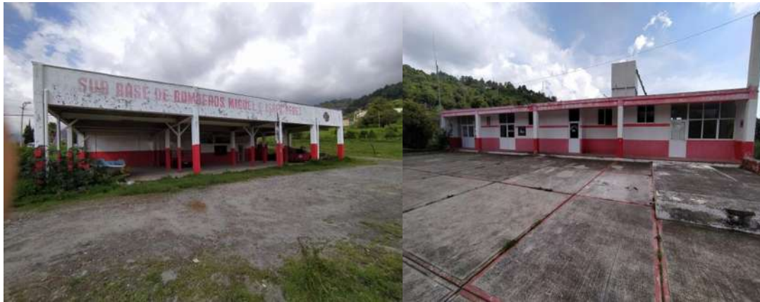
imagen 9.1 Estacionamiento de patrullas y motobombas. Fotos tomadas por el autor (octubre 2019)
