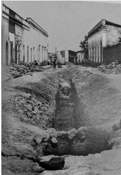
Imagen 12 Introducción del drenaje por el ayuntamiento en la calle Cuauhtémoc a base de tabique y cuñas año de 1933. Fuente Zitácuaro monografía fotográfica
