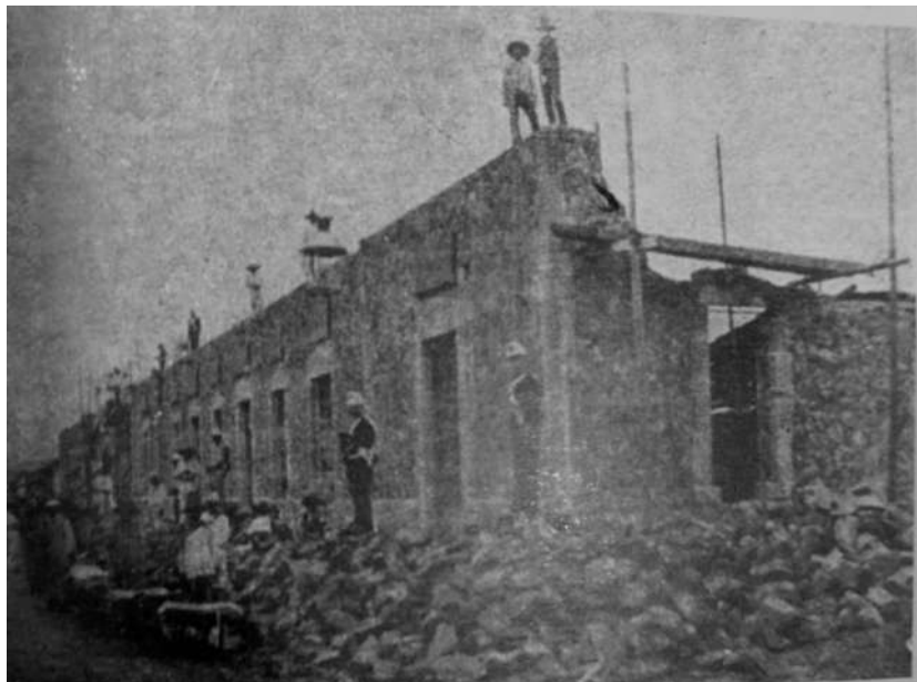
Imagen 11 Palacio municipal en plena construcción. Fue entre los años 1869 y 1871. Fuente Zitácuaro monografía fotográfica
