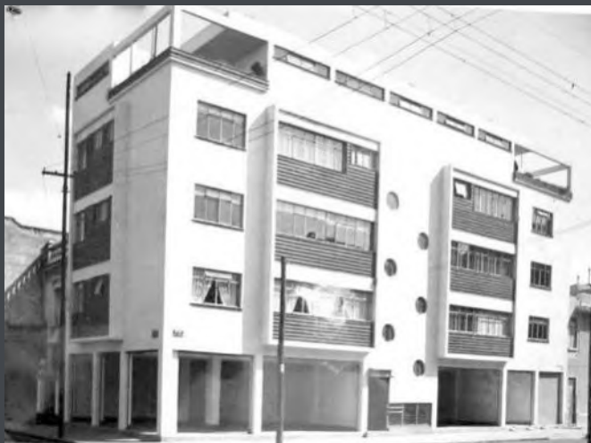
Imagen 12. Edificio de apartamentos (1942) de cuatro niveles, en c/Lisboa. Fuente: Centro Nacional de Conservación y Registro del Patrimonio Artístico Mueble, INBA
