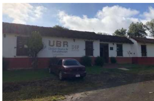
Imagen 44. Fotografía tomada por Calderón Sánchez Jonatan Martin
