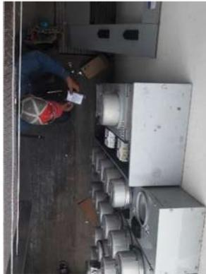
Suministro e instalación de interruptor termomagnético en caja moldeada, gabinete Nema 1 uso interior Marco H, 150 amperes de marco, Marca SQUARE D modelo HDL36070, 3 polos 70 amperes, 240 volts.
