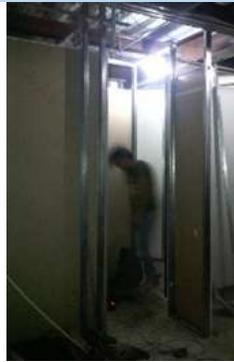
Suministro y fabricación de lambrín de tablaroca una cara, a base de una hoja de panel de yeso USG., de 1/2" de espesor, sobre perfil metálico con poste metálico 63.5 mm, cal.26 @ 61 cm.
