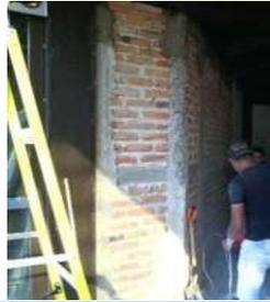
Aplanado de cemento-arena proporción 1:4, acabado fino a plomo, de hasta 2.98 mts de altura
