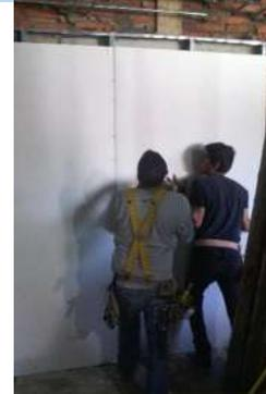
Suministro y fabricación de lambrín de tablaroca "WR" en zonas húmedas, a base de una hoja de panel WR de 1/2" de espesor, sobre bastidor metálico de canaleta y poste de lámina galvanizada 635-26 colocados @ 60cms.
