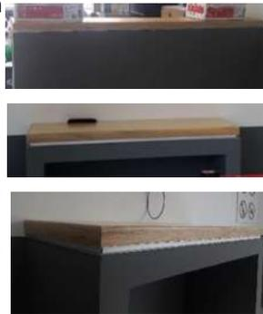
Fabricación y colocación de 2 Barras de Conteo en Bóveda con cubierta a base de tablón de pino de 1 1/2" barnizado acabado natural a dos manos, con bastidor de pino. Dimensiones 0.60 y 0.30 m de ancho y hasta 1.80m
