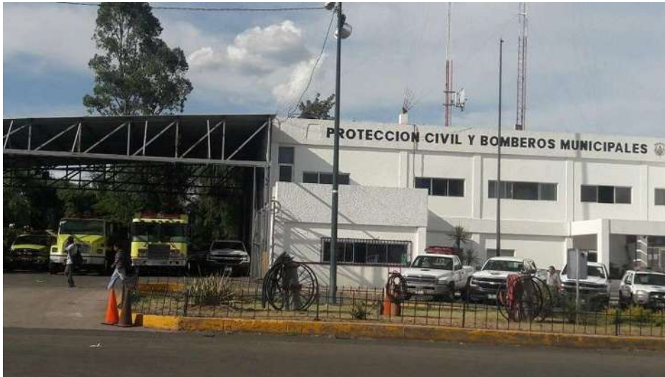
Imagen2.- Protección civil Morelia Michoacán (Foto tomada de google)
