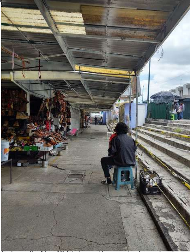
Fotografía No. 49. Elaboración propia, tomada el 10/10/2019. Pasillo del interior del mercado
