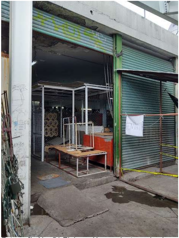
Fotografía No. 51. Elaboración propia, tomada el 10/10/2019. Pasillo del interior del mercado
