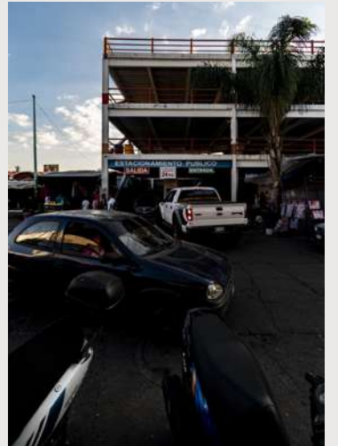
Fotografía No. 05 Elaboración propia tomada el 19/09/2019
