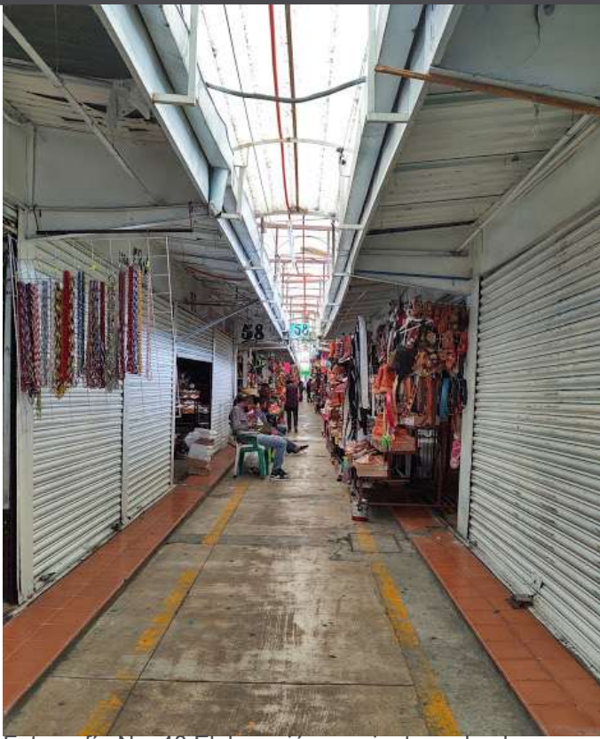
Fotografía No. 48. Elaboración propia, tomada el 10/10/2019. Pasillo del interior del mercado
