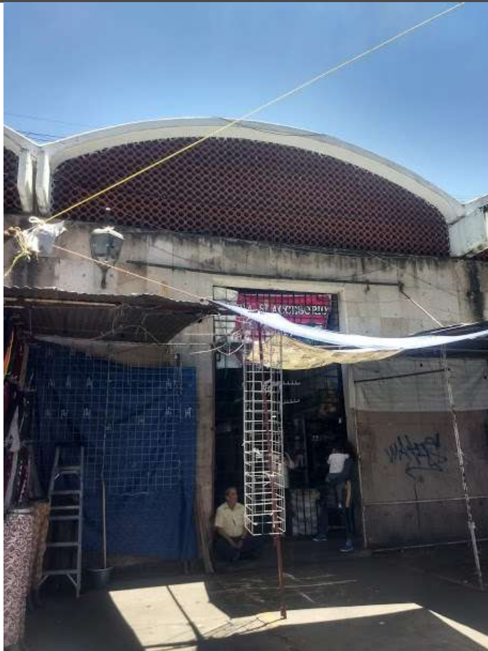
Fotografía No. 30. Elaboración propia, tomada el 02/10/2019. Fachada principal, Av. Lázaro Cardenas
