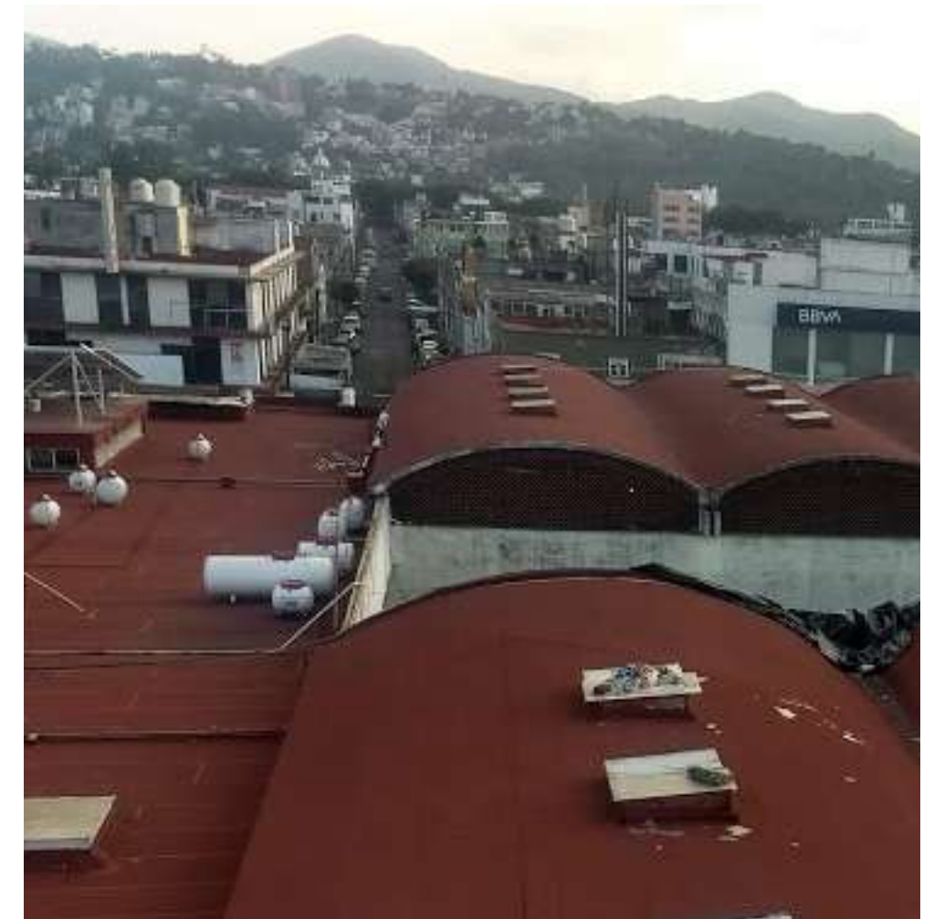
Fotografía No. 27. Elaboración propia, tomada el 24/09/2019. Cubiertas del mercado
