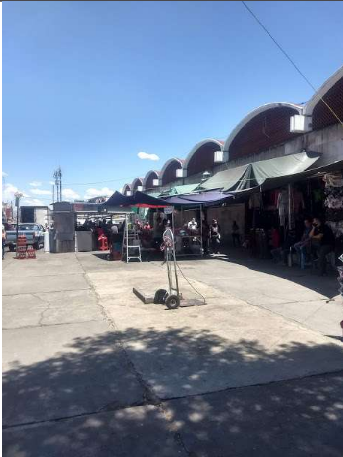
Fotografía No. 31. Elaboración propia, tomada el 02/10/2019. Fachada principal, Av. Lázaro Cardenas
