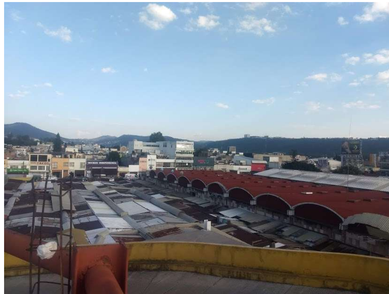
Fotografía No. 26. Elaboración propia, tomada el 24/09/2019. Cubiertas del mercado
