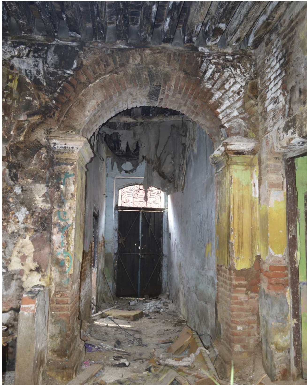
Fotografía 8: Arco pasillo principal. Fotografía: Teresa García
