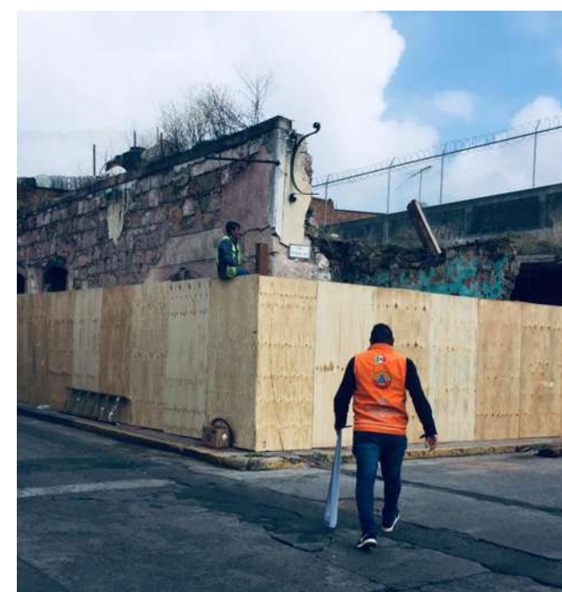
Fotografía 2: Fachada Fuente: Coordinación del centro histórico
