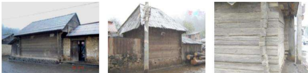
Fig. 11 Elementos de madera ensamblados para la formación de muros, Obtenido de: (La troje michoacana, Bedolla).
