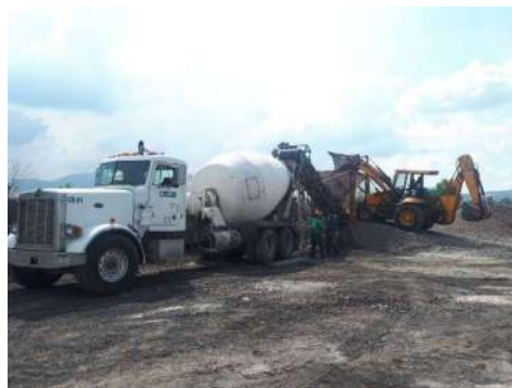
Ilustración 3 Equipo y Maquinaria para la dosificación de concreto.
