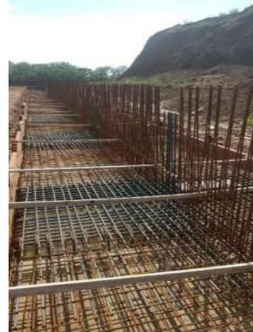
*Ilustración 34 Fotografía del armado de una zapata corrida obtenida de Google.com*
