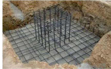
*Ilustración 35 Fotografía del armado de una zapata aislada obtenida de Google.com*
