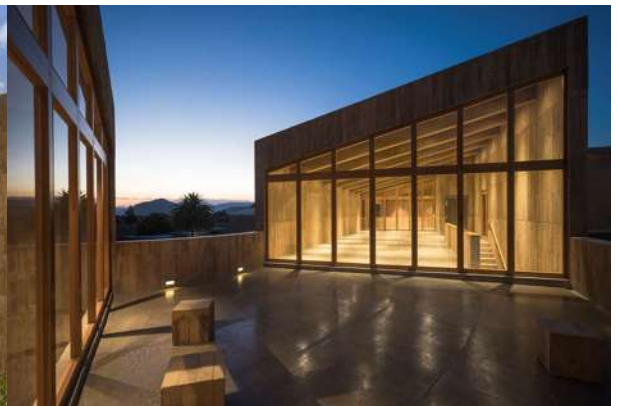
Imagen 19.- Exterior principal Centro cultural comunitario Teotitlán del Valle
