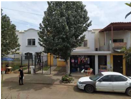
Imagen 35.- Villas del Pedregal estado actual con transformación por los usuarios
