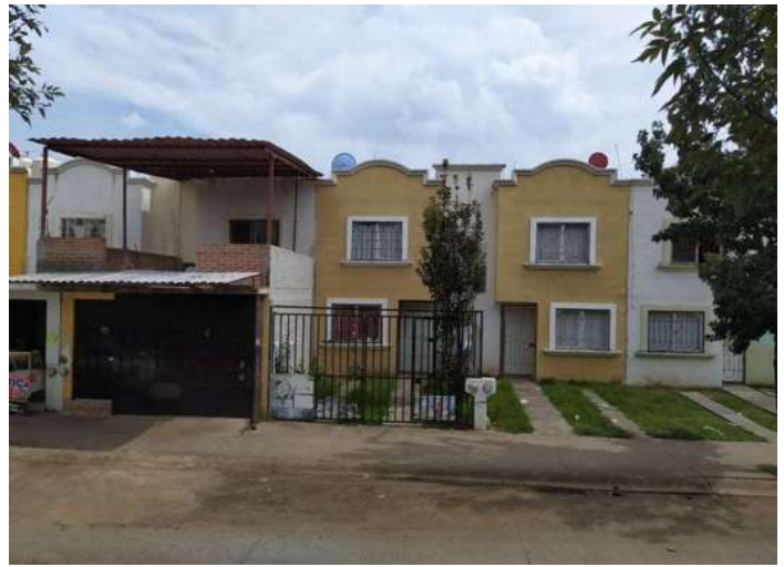
Imagen 34.- Villas del Pedregal estado actual con transformación por los usuarios
