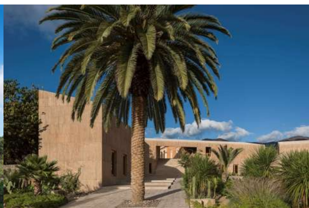
Imagen 17.- Exterior principal Centro cultural comunitario Teotitlán del Valle
