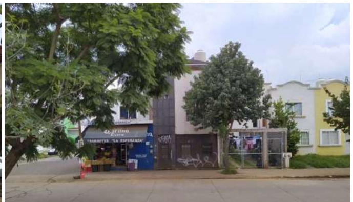
Imagen 36.- Villas del Pedregal estado actual con transformación por los usuarios
