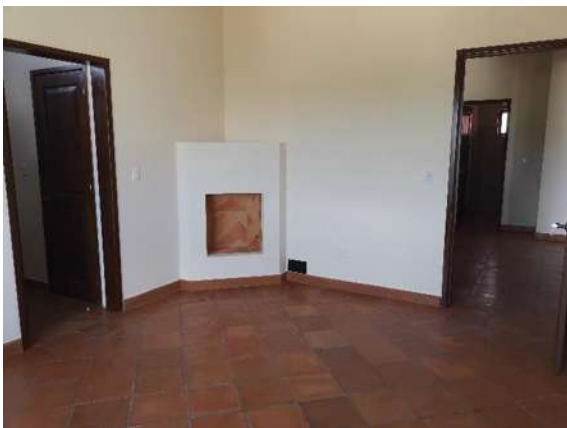
Imagen 109 Limpieza fina de detallado de vivienda.
