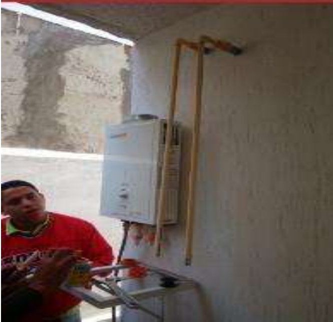
Imagen 21 Prueba de calentador de paso.
