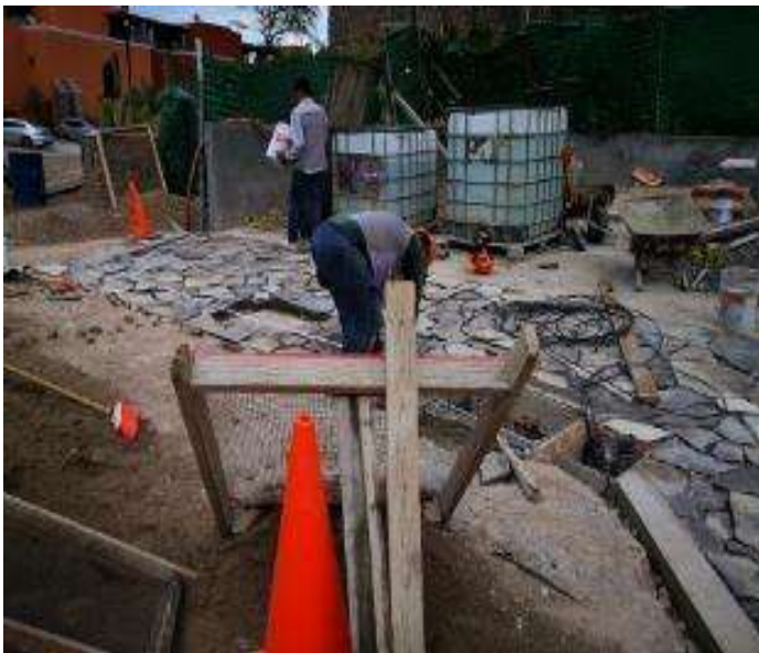
Imagen 118 Colocación de laja en área de vialidad. Nota: La colocación de laja se realiza sobre un firme de concreto con una resistencia de f'c=250 \text{ kg/cm}^2 con malla electrosoldada 6-6/10-10, la piedra laja que en general es una roca lisa, plana y poco gruesa, junteada y pegada con mortero arena.
