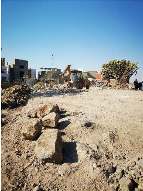
Imagen 123 Limpieza y corte del terreno en área de casa club 02 y área de jardines. Nota: Este proceso se realiza mediante maquinaria pesada como retroexcavadora y camiones de volteo con capacidad de 14 m3.
