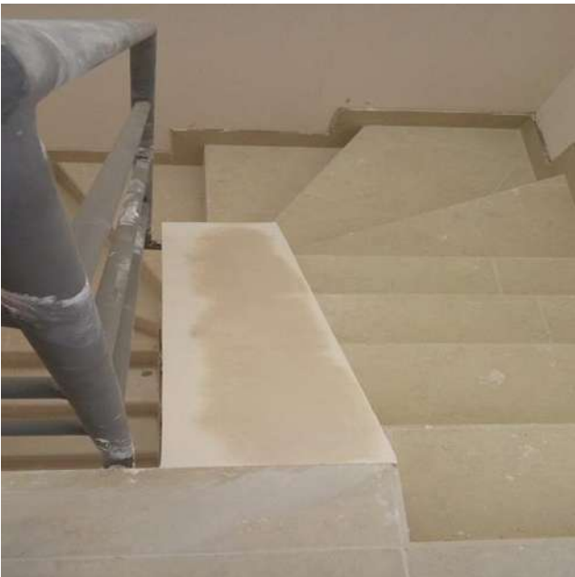
Imagen 69 Colocación de herrería y piso.
