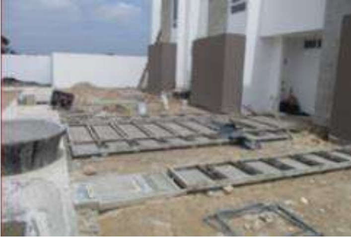
Imagen 73 Colado de huellas.
