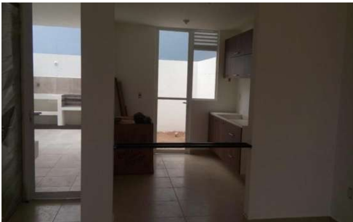
Imagen 71 Colocación cableado, cocinas y carpintería.
