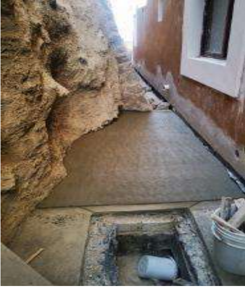
Imagen 119 colado de firme y hechura de registros pluviales.
