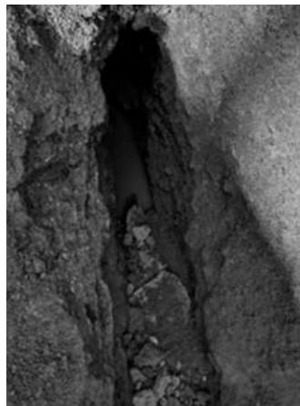
Imagen 111 Fisura en terreno natural. Nota: al momento de realizar la excavación para la zapata se encontró una grieta en terreno natural.
