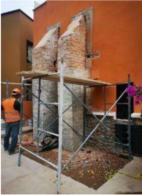
Imagen 121 Reforzamiento de contra fuertes. Nota: el reforzamiento se lo contra fuertes se realizó mediante la aplicación de concreto en su cimentación para ello se tuvo que retirar el revestimiento de piedra bola, abrir el firme y extraer el relleno de tepetate para después colar una zapata reforzándola con acero según el calculo emitido por el estructurista.
