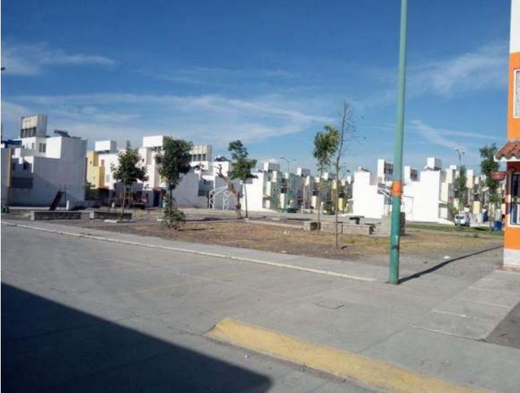
Imagen 24 Vista panorámica de área de juegos y vivienda en el desarrollo El Rehilete. Imagen. Recuperada de: https://www.icasas.mx/venta/casas-guanajuato-villagran/casa-venta-rehilete-villagran-5-min-celaya_2419682
