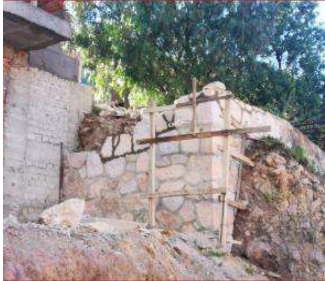
Imagen 120 muro tapón. Nota: SE realiza con cantera, se pega y juntea con mortero arena, se hace para revestir los cortes del terreno natural.
