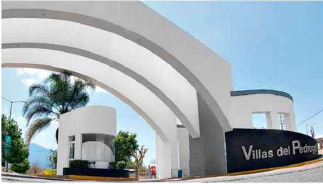
Imagen 22 Acceso del desarrollo Villas del Pedregal. Imagen. Recuperada de: https://www.mimorelia.com/construccion-del-nuevo-acceso-a-villas-del-pedregal-inicia-este-ano-moron
