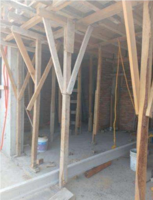
Imagen 102 Habilitado y colocación de cimbra. Nota: A lo que se refiere a la cimbra en este sistema constructivo se elimina la cimbra de contacto como los es el triplay, duela, etc. Ya que solamente utilizamos mdrinas que puede ir a cada 1.25 cm de separación y un barrote que se coloca al centro en las bovedillas a cada 15 cm o más.
