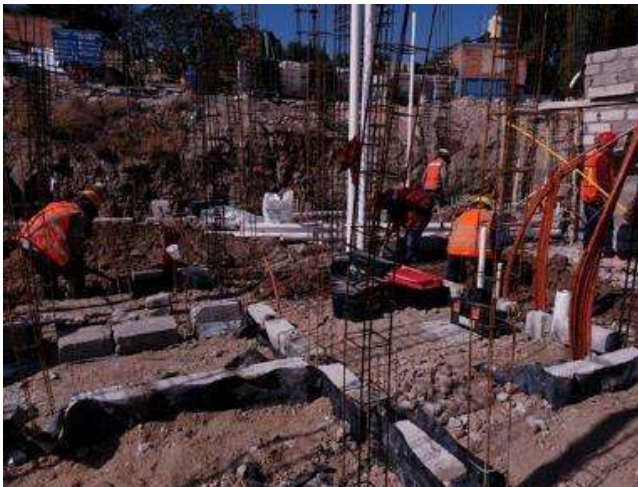
Imagen 96 Habilitado y colocación de acero.
