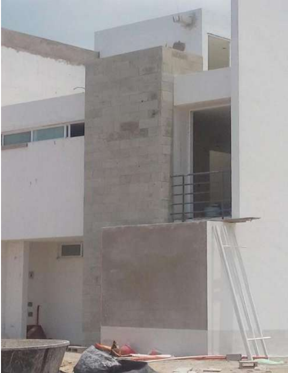
Imagen 70 Colocación de la cantera, cancelería y primera mano de pintura.
