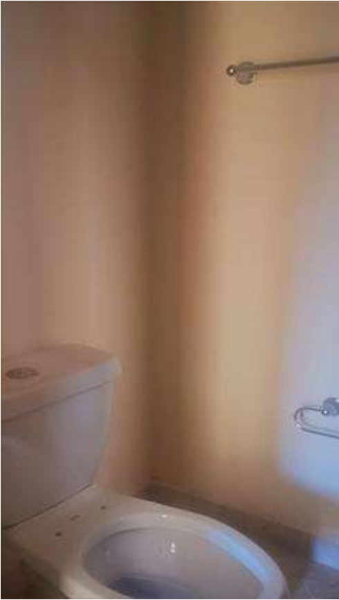
Imagen 108 Colocación de muebles y accesorio sanitario. Nota: se coloca en todos los baños y los modelos son según el proyecto, estos deben de estar en perfectas condiciones y deben de estar funcionando bien.
