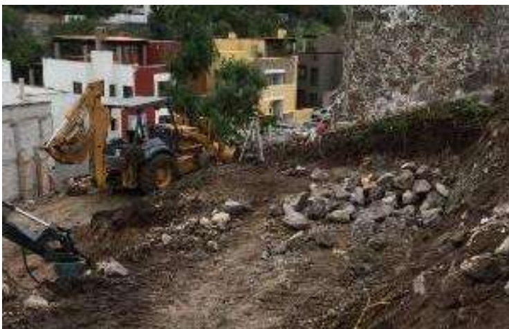
Imagen 94 Limpieza y movimiento de tierra.
