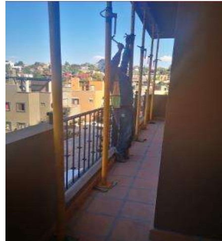
Imagen 116 Apuntalamiento. Nota: se apuntalaron los volados que tuvieron problemas estructurales en tanto se realizaban los trabajos de reforzamiento.
