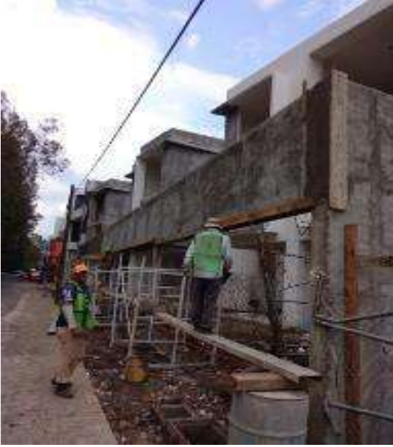
Imagen 18 Desarrollo Las Acacias, ubicado en la Cd. de Morelia Mich. Vista de fachadas principales de los prototipos A05 en proceso de albañilería. Nota: En estos procesos llevaba una inspección ocular en cada proceso constructivo.
