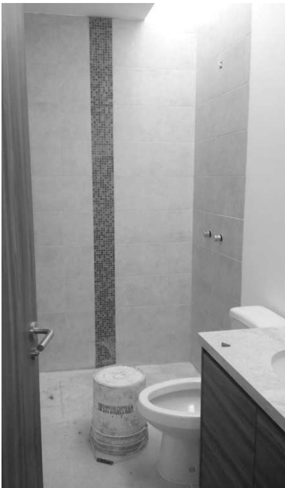
Imagen 72 Colocación de muebles de baño y accesorios.
