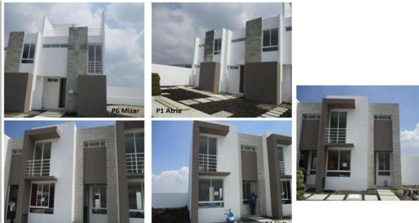
Imagen 74 Colocación de tierra vegetal y 2da. mano de pintura.
