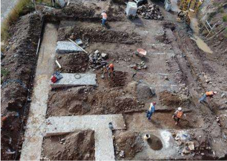
Imagen 95 Trazo, nivelación y excavación de zapatas.
