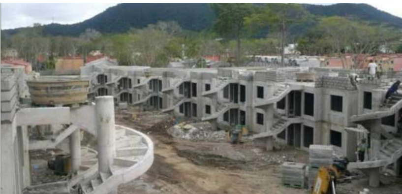
Imagen 7 Desarrollo Morrococoy, vista panorámica del condominio 56, prototipo Malaquita. Nota: Colabore durante toda la supervisión de obra.
