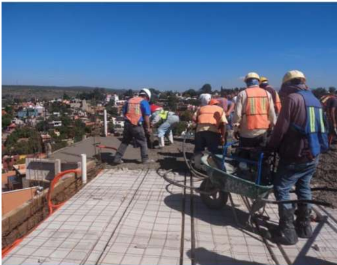
Imagen 104 Colado de losa, trabes y cerramiento. Nota: El colado de la capa de compresión de 5 cm se debe de colar con la capa superficie mojada y se tapan todos los huecos de la bovedilla, la losa ya colada se deberá de mantener húmeda durante los 7 días siguientes y después de estos días se podrán quitar los puntales.
