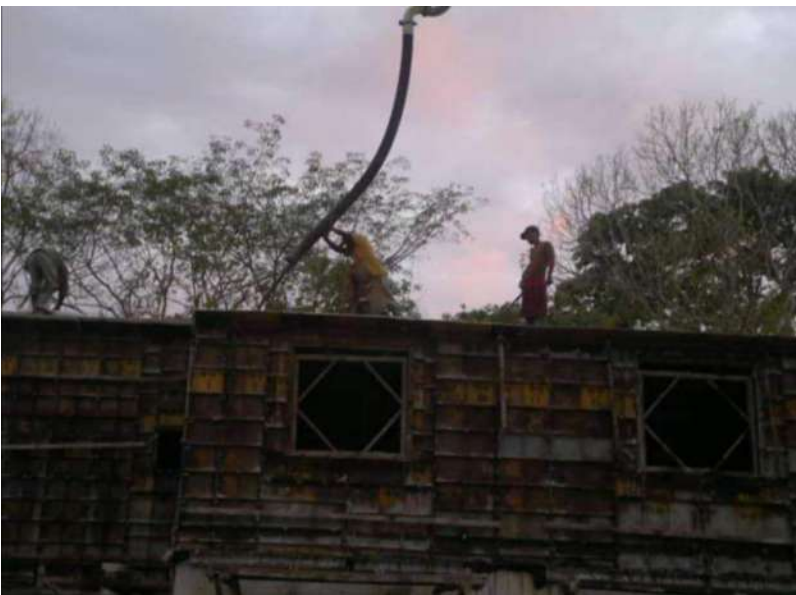
Imagen 8 Desarrollo Flamingos, Colado de prototipo Diamante Ampliado, Nota: En esta etapa fungí como supervisor de moldes.
