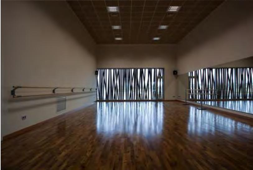
Existen tres salas, una central y dos laterales, simétricas, de mayor tamaño. Las tres cuentan con grandes huecos acristalados, que dirigen la vista hacia el paisaje, celosías formadas por perfiles tubulares inclinados de acero oxidado protegen de las vistas exteriores y del exceso del soleamiento, al tiempo que incorporan al espacio interior un interesante movimiento mediante un juego de luces y sombras.
