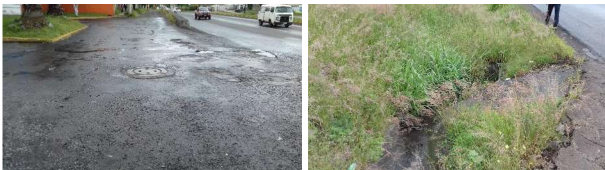
IMAGEN 15. Ubicación del pozo de visita de drenaje, por la carretera Morelia–Guadalajara. Foto: Jorge Gómez Cruz
