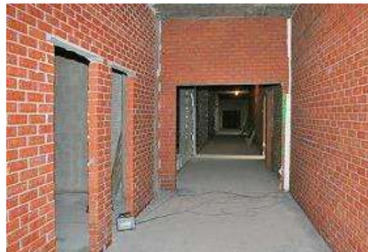
IMAGEN 34. Muro de carga, Tabique. Fuente: https://www.ecured.cu/Muro [30-10-19]
