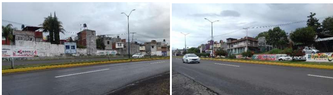
IMAGEN 24. Construcciones de casa habitación de 2 niveles. Foto: Jorge Gómez Cruz
