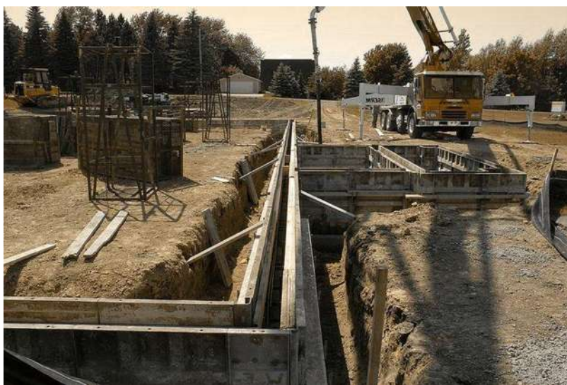
IMAGEN 31. Zapata corrida. Fuente: https://www.eadic.com/tipos-de-cimentacion-descripciones/
