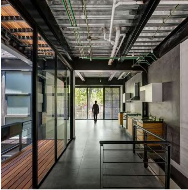
Fig. 75. Plafón de Losacero con instalación eléctrica expuesta, ColiRoma CientoVeinteOcho / ARQMOV Workshop Fuente: archdaily.mx
