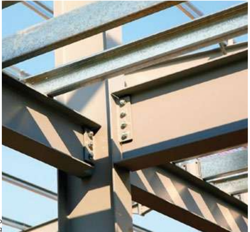
Fig. 74. Estructura de acero Fuente: cmic.org
