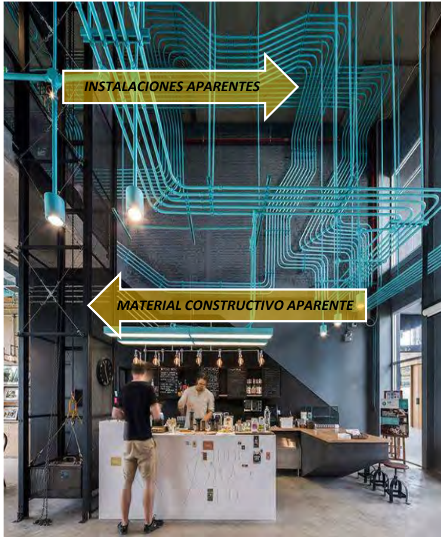
Ilustración 15 Arquitectura brutalista exposición de instalaciones
