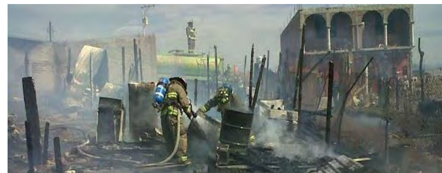
Ilustración 8 Incendio en la colonia ciudad jardín Morelia, ocurrió el 22 de diciembre 2014
