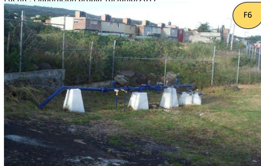
Ilustración 69 Pozo de agua primer plano terreno segundo plano y al fondo fraccionamiento Juan Álvarez
