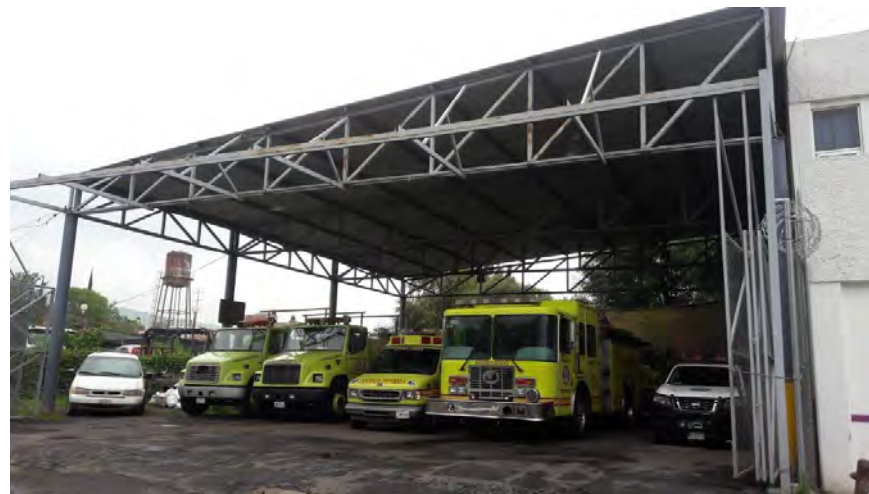
Ilustración 32 Área de estacionamiento estación de protección civil y bomberos de Morelia Fuente: Elaboración propia 10/Julio/2018
