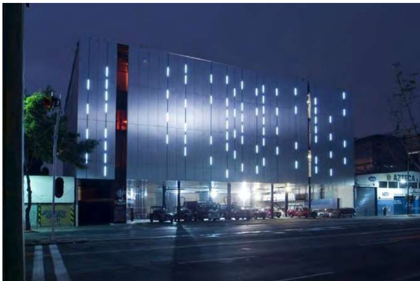
Ilustración 28 Fachada principal (noche) estación de bomberos AVE FENIX
