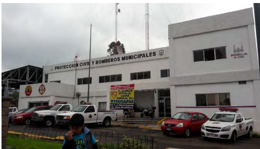
Ilustración 31 Fachada estación protección civil y bomberos de Morelia Fuente: Elaboración propia 10/Julio/2018
