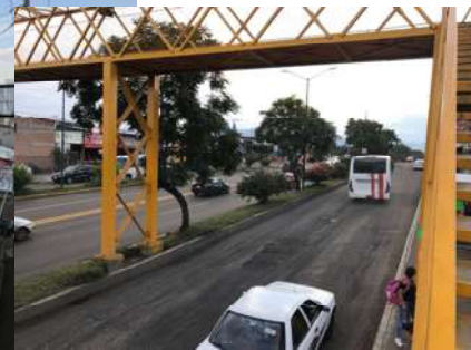
Imagen 5.5.2 Puente peatonal, RSC
