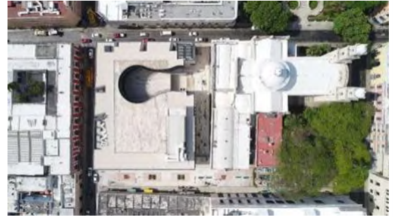
12 Vista aérea de palacio de la música, fotografía por Onnis Luque. fuente: https://www.archdaily.mx/mx/901325/palacio-de-la-musica-alejandro-medina-arquitectura-plus-reyes-rios-plus-larrain-arquitectos-plus-munoz-arquitectos-plus-quesnel-arquitectos
