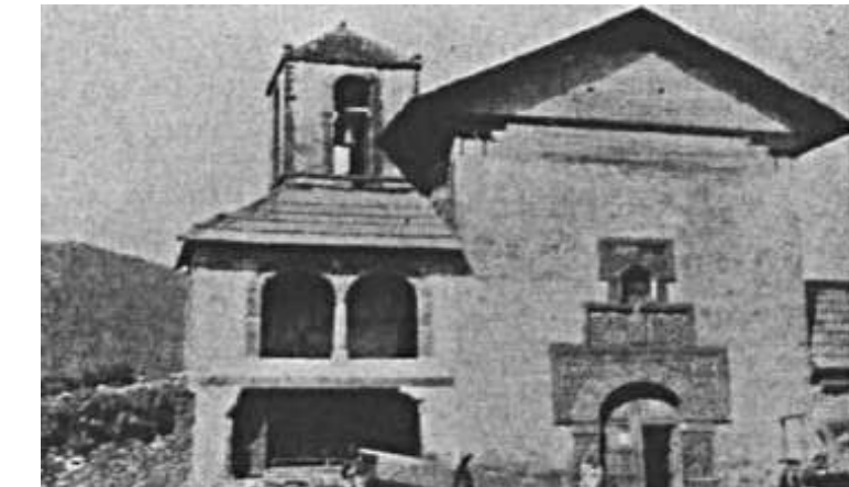
Imagen 61. Iglesia. Conjunto de capilla abierta y fachada. Fotografía Francisco José Rhode, 1946.
