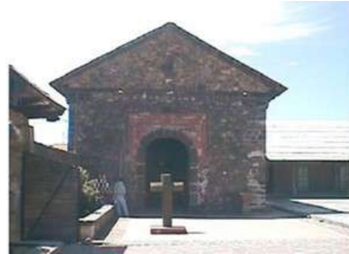
Imagen 59. Capilla o Huatápera. Fotografía autor Febrero 2019.
