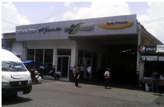
Imagen 16. Terminal de Autobuses de Zacapu, vista desde la Av. Morelos. Recuperada de: https://www.wikiwand.com/es/Terminal_de_Autobuses_de_Zacapu
