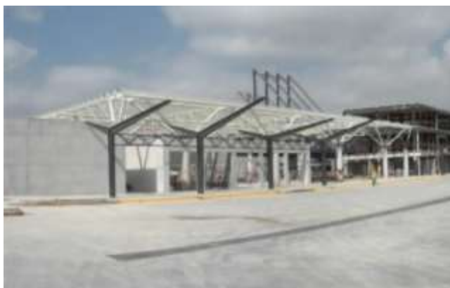
Estructuras de Acero
