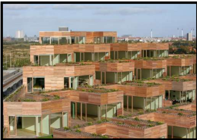
Fotografía 40 Mountain Dwellings vista por fuera https://www.archdaily.mx/mx/02-338873/mountain-dwellings-big-and-jds?ad_medium=widget&ad_name=recommendation
