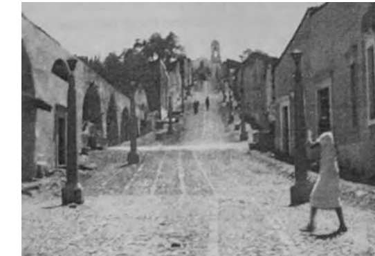
Gráfico 3.08, Puruándiro: Acueducto "Mariano de la Piedra", 1900 apróx.
