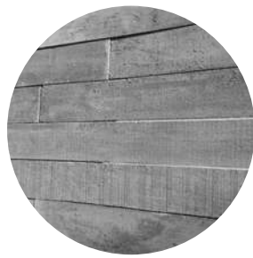
Losa de vigueta y bovedilla de concreto aparente
