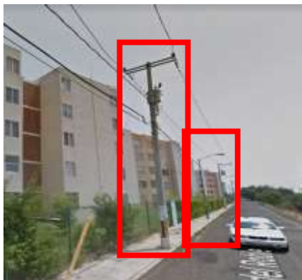
Ilustración 32. energía eléctrica Tomada de google maps
