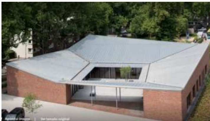
Ilustración 51 fachada del centro comunitario altenessen Tomada de Archdaily
