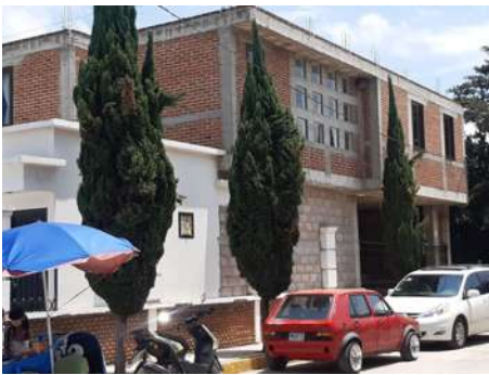
Imagen 66. Construcción cercana ala predio donde se pueden observar los materiales utilizados para su edificación
