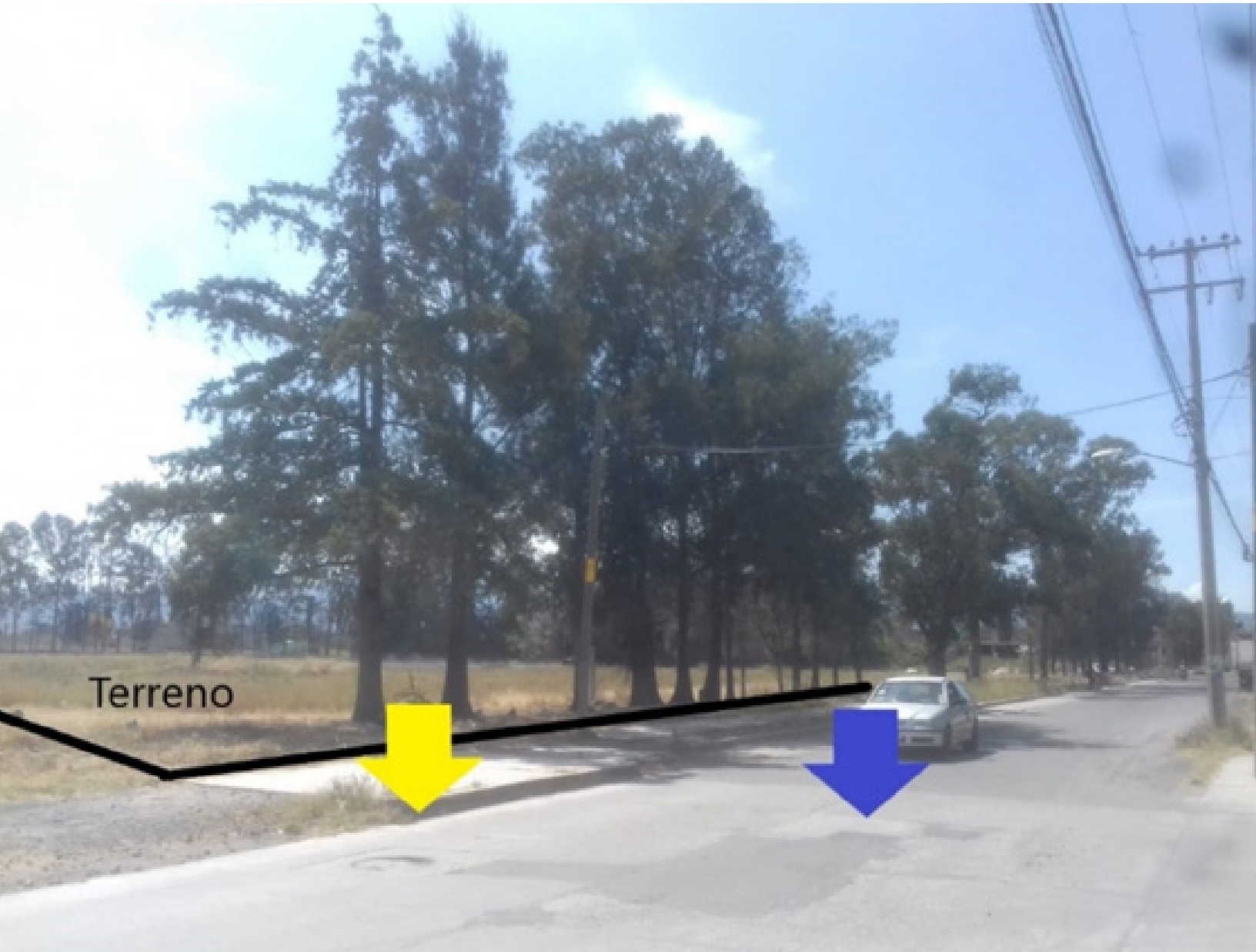
Imagen 16. Servicios de agua potable y alcantarillado. Fotografía tomada por Socorro Lizeth Escobedo Uribe
