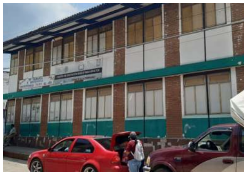
Imagen 61. de la fachada lateral del Centro de educación para adultos, ubicado en la zona centro, se puede observar en su forma un sistema de módulos, repetición en vanos de ventanas
