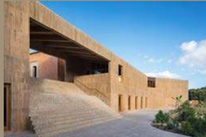
Figura 10.- Centro comunitario Teotitlan del Valle. (PROODUCTORA, 2017)
