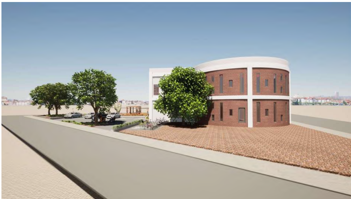
Vista de fachada este.
