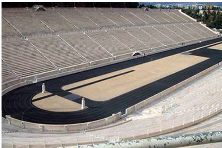
Estadio Panathinaikos" Obtenido: https://sobregrecia.com/2013/05/03/los-estadios-de-la-antigua-grecia/ [08/06/2020]
