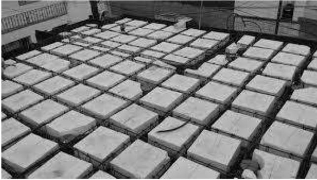
Figura 38: Losa reticular; fuente:
