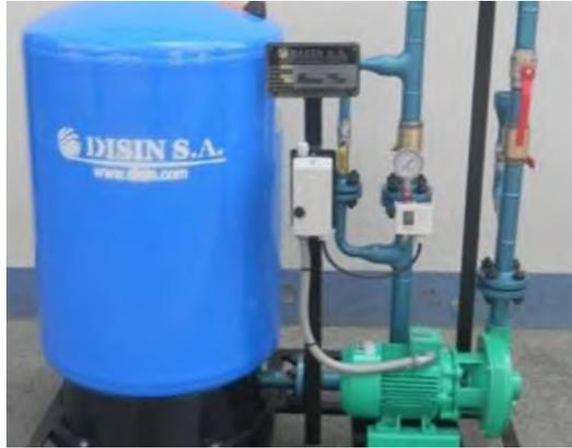
Figura 40: Hidroneumático; Fuente:
