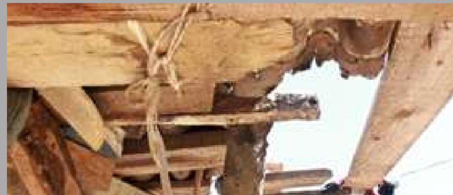
Laminas de policarbonato roja, fajillas de madera acerradas, sujetas con clavos y alambre recocido
