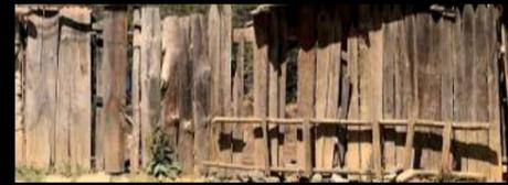
Tablas de madera acerrada ancladas con clavos y alambre recocido
