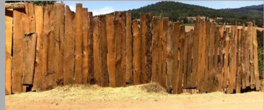
Tablas de madera acerrada ancladas con clavos y alambre recocido
