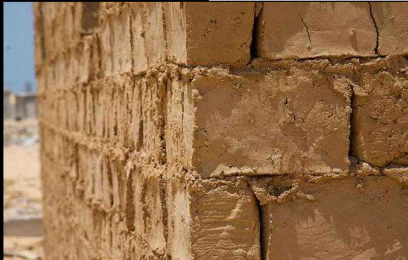
manualmente con el mismo material de la fabricación de los bloques. Los bloques de tierra serán el sustituto del material que predomina hoy en día en viviendas consolidadas de nuestra zona de estudio, se utilizará en la construcción de muros, apilándolos manualmente con el mismo material de la fabricación de los bloques.
