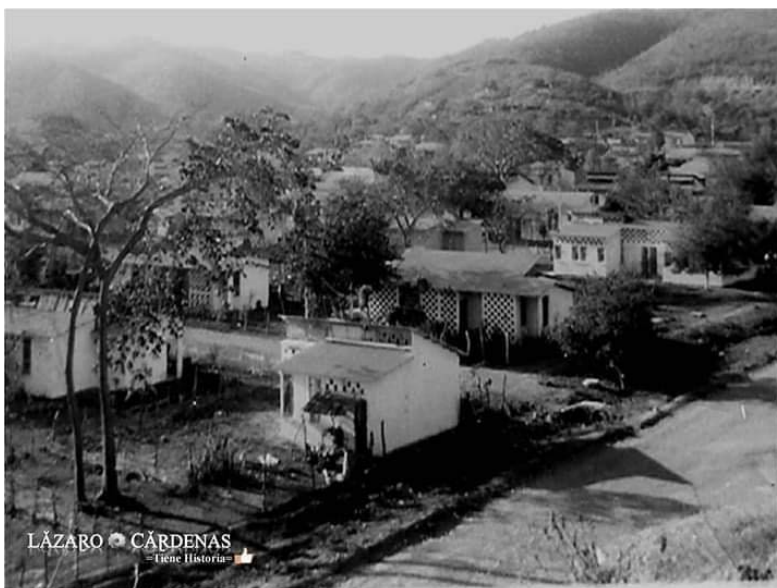
Imagen 11. Campamento obrero, 1970. Fuente: Lázaro Cárdenas – Tiene Historia. Facebook.
