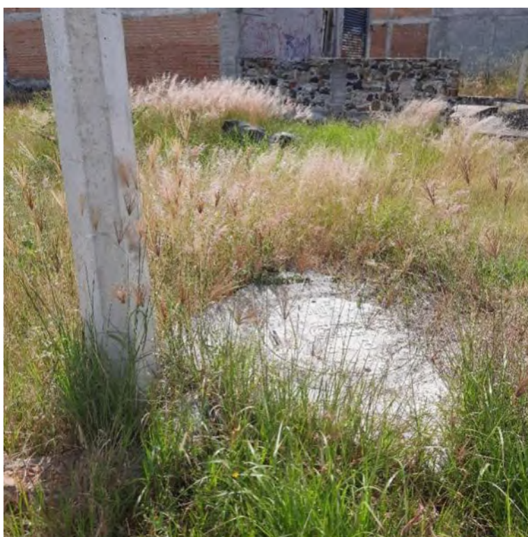
fig.3. 14 Servicio de energía eléctrica. Fuente: propia
