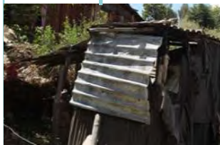
Lamina acanalada de metal, unión con tapa-roscas y clavos
