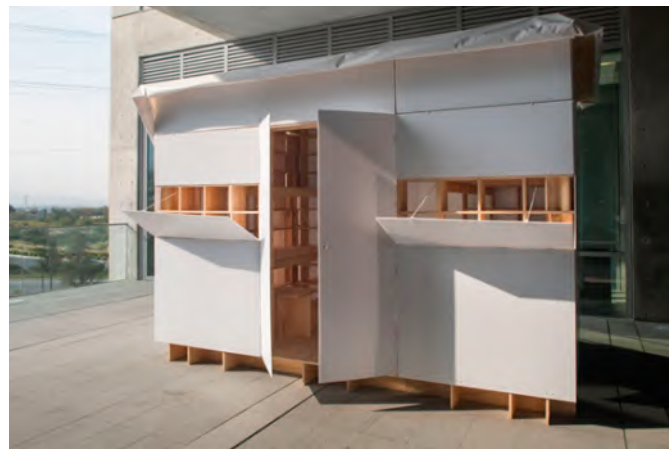
Imagen 5.6: Recubrimiento de exterior con membrana textil.
