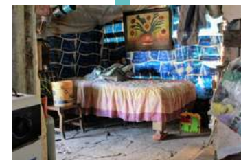
Recubrimientos de cartón y lonas en muros de habitaciones contra las inclemencias del tiempo.
