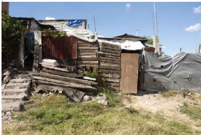
Lamina acanalada de cartón, utilizado para cubrir el exterior, con clavos y tapa-roscas
