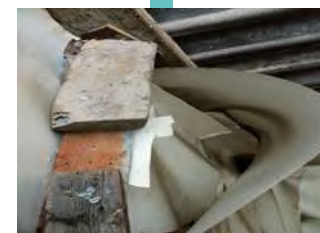
Lamina acanalada de cartón, fajilla de madera y polines como soporte, con clavos y tapa-roscas.
