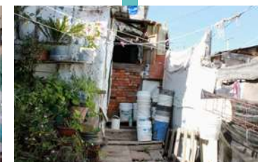
Recubrimientos de cartón y lonas en muros de habitaciones contra las inclemencias del tiempo.
