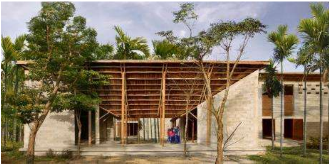
Imagen 29. Fachada, Casa Comunitaria Cam Thanh. Fuente: https://www.archdaily.mx/mx/768157/casa-comunitaria-de-cam-thanh-1-plus-1-2
