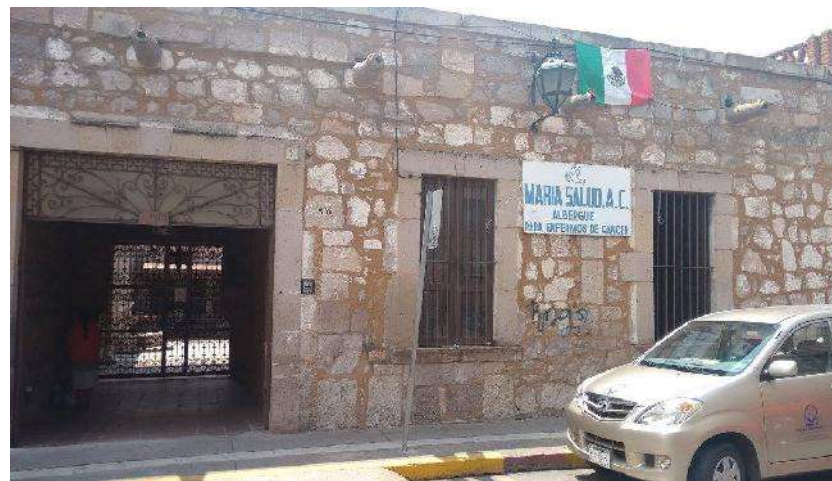
Imagen 5. Fachada principal de Albergue María Salud A.C. Tomada de Facebook, 18 octubre de 2016.
