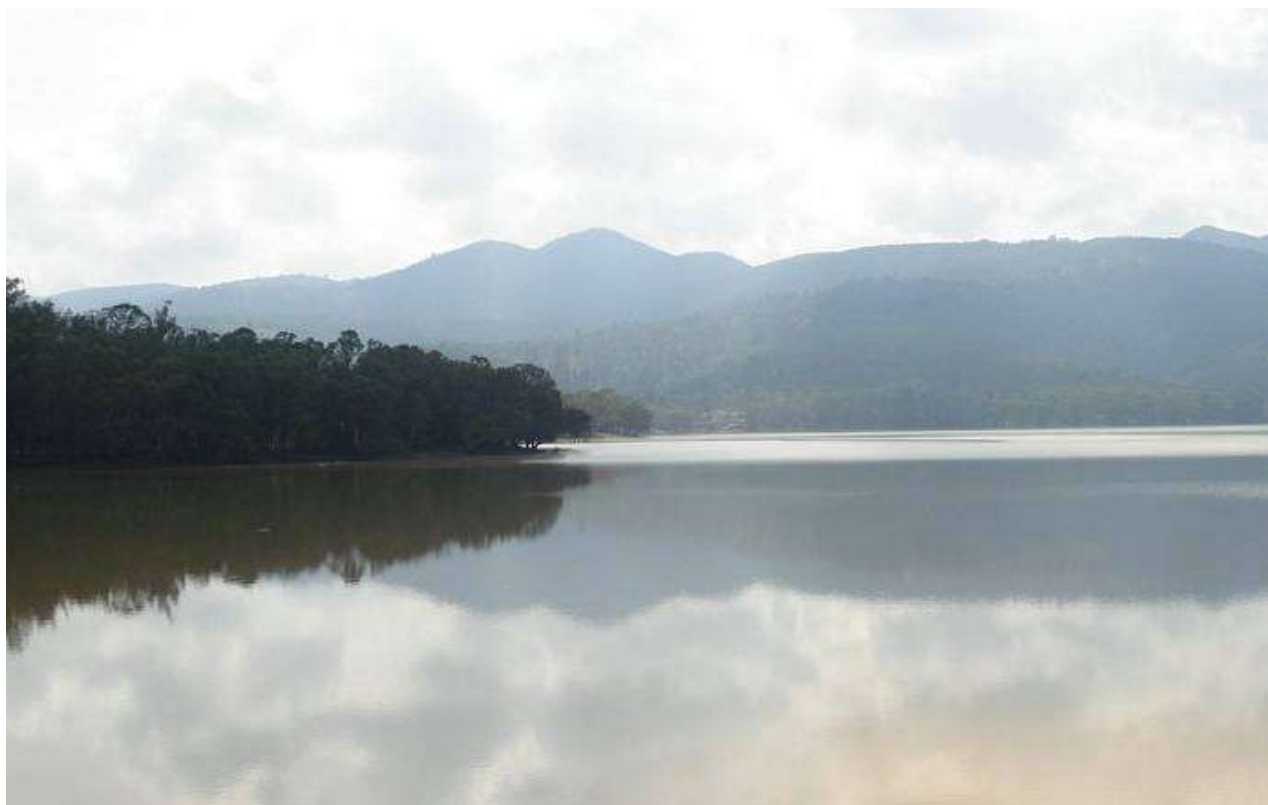
Imagen 36, Presa de Cointzio, https://www.lavozdemichoacan.com.mx/morelia/inicia-desfogue-de-presa-cointzio-monitorean-rios-y-presas/
