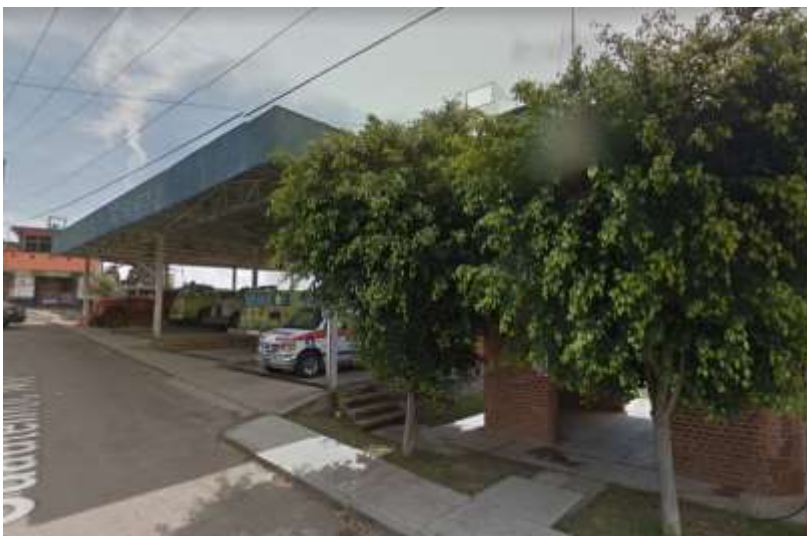
fig.40: fachada norte de la central de bomberos, se aprecian los materiales constructivos ya mencionados, así como el equipamiento de los vehículos, fuente: Fire station. 2020. Fire Station. [Online] Available at: < https://www.google.com/maps/place/Estaci%C3%B3n+De+Bomberos/@19.7060669,-100.5536097,118m/data=!3m1!1e3!4m5!3m4!1s0x85d2cbbf9f349a5b:0xe4e0e9eccf84e590!8m2!3d19.7061715!4d-100.5534109 > [Accessed 15 October 2020].
