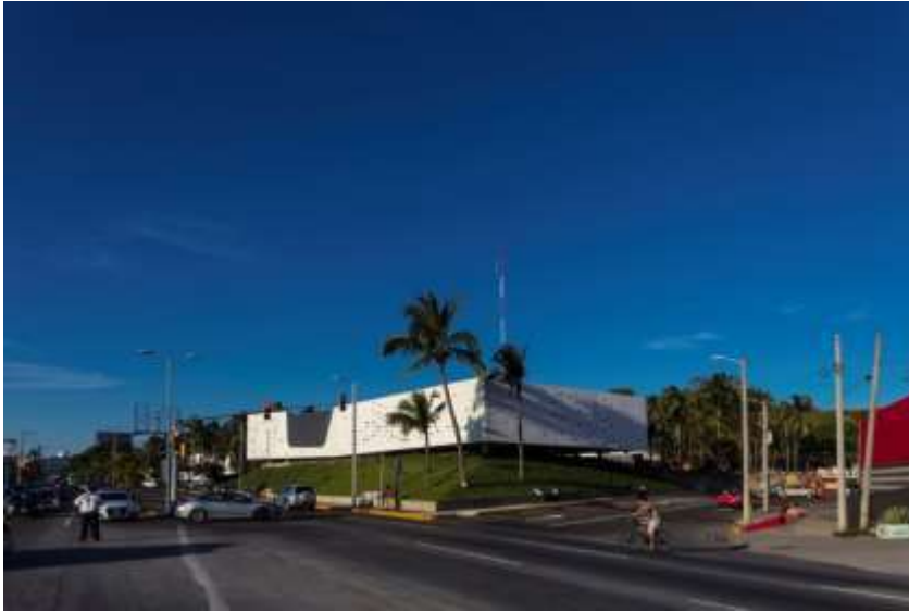
fig.37: integración con el entorno central de
