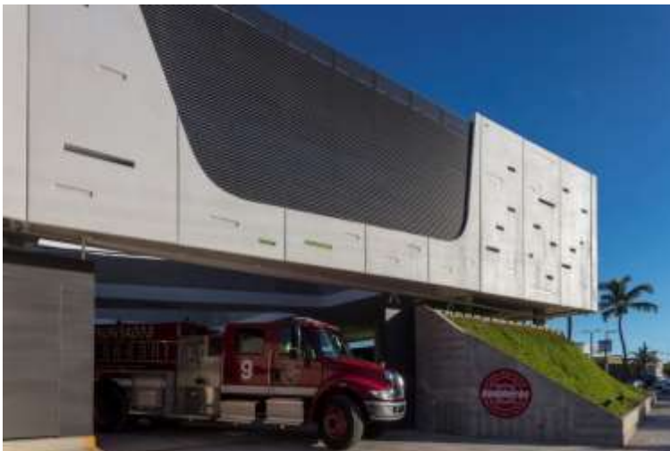
fig. 30: fachada posterior de central de bomberos, boca del rio,
