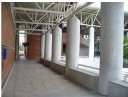
Imagen 98. Pasillo interior, de planta alta 63 .
